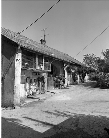
Façade extérieure vue de trois quarts. Phot. Dominique Dominguez IVR43_19803900055X
