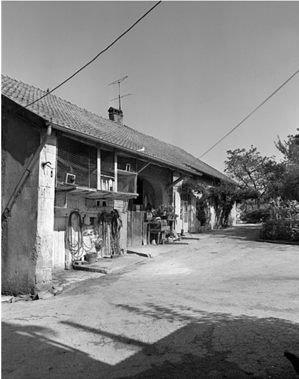
Façade extérieure vue de trois quarts.
