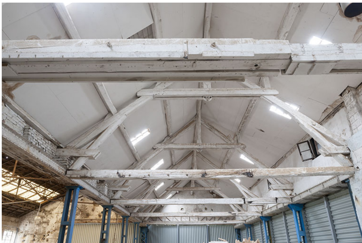
Charpente de l'atelier d'usinage.
