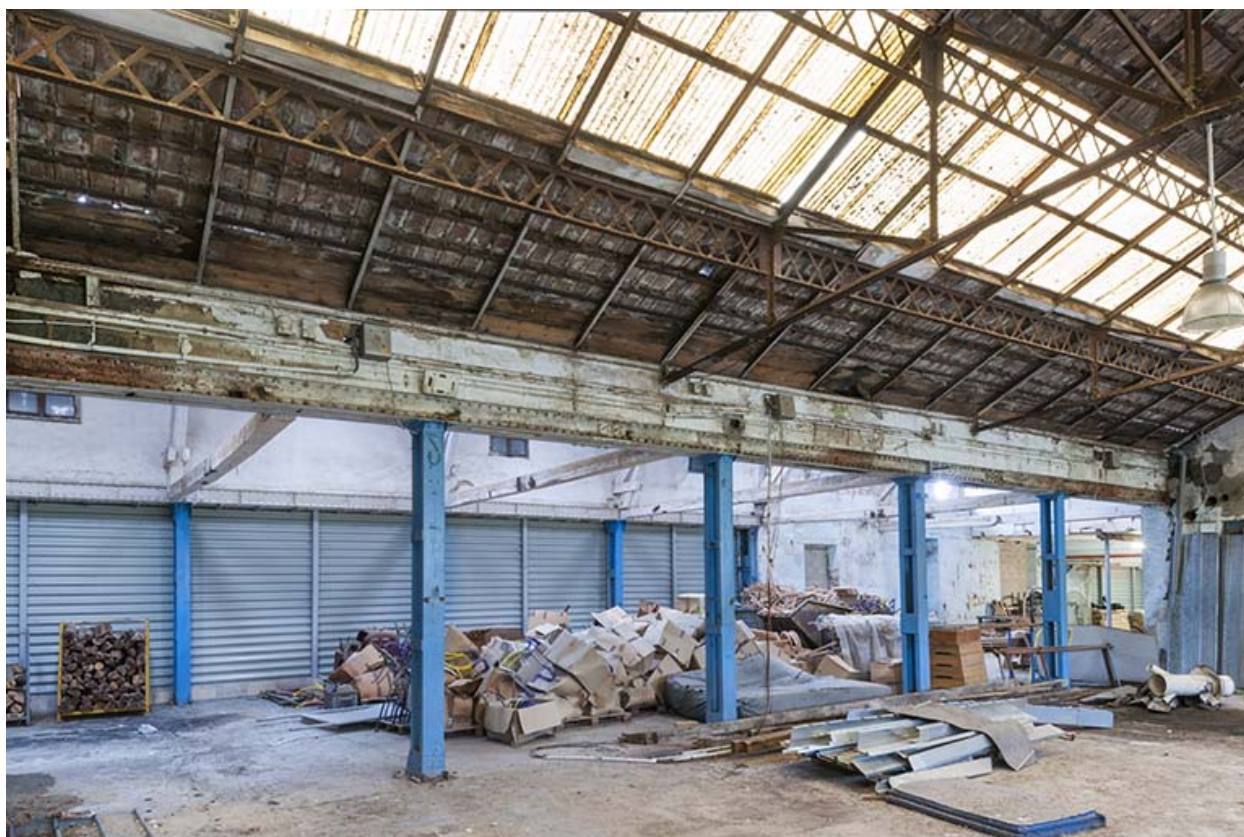
Atelier d'usinage. Vue intérieure de trois quarts.
