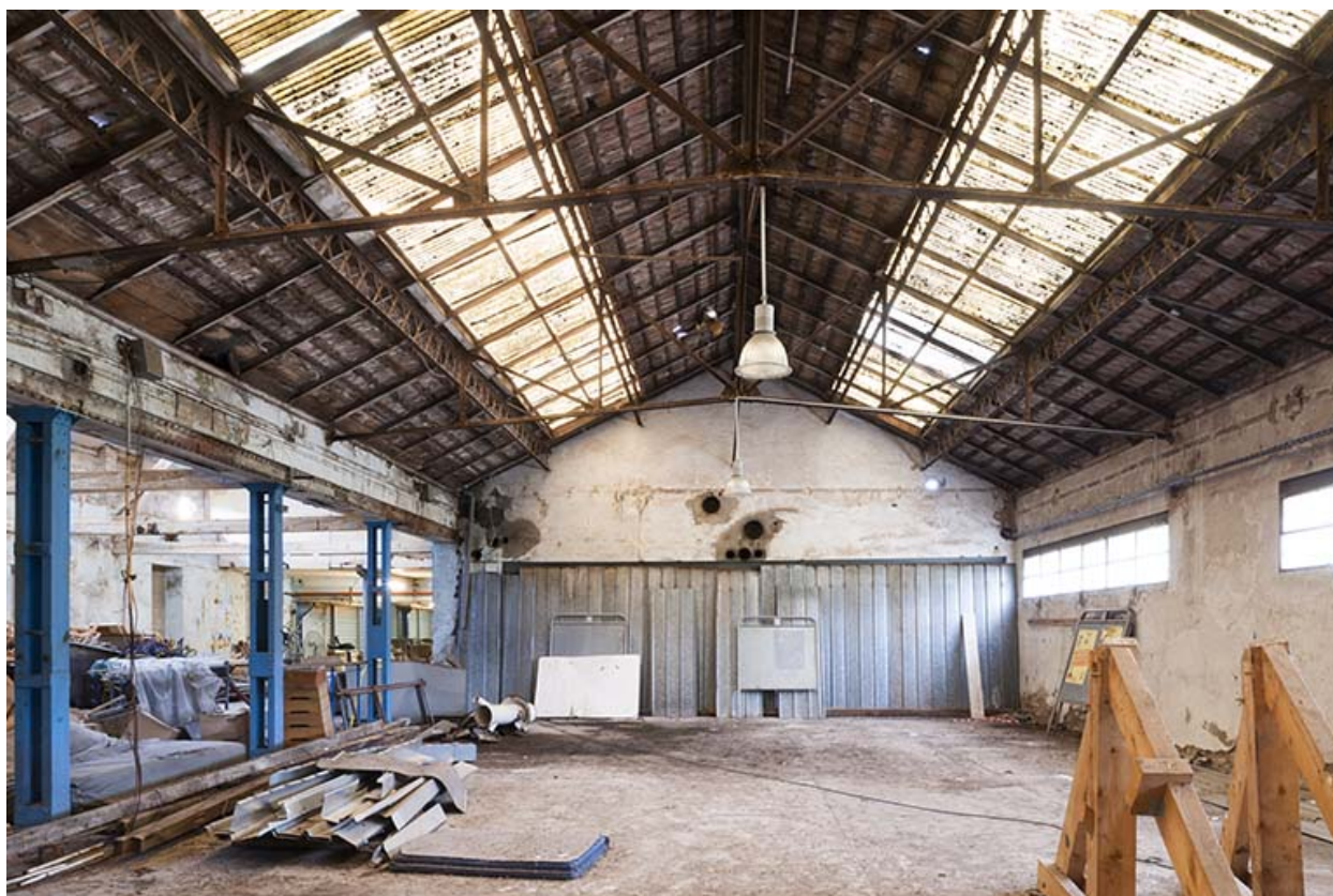
Atelier d'usinage. Travée est.
