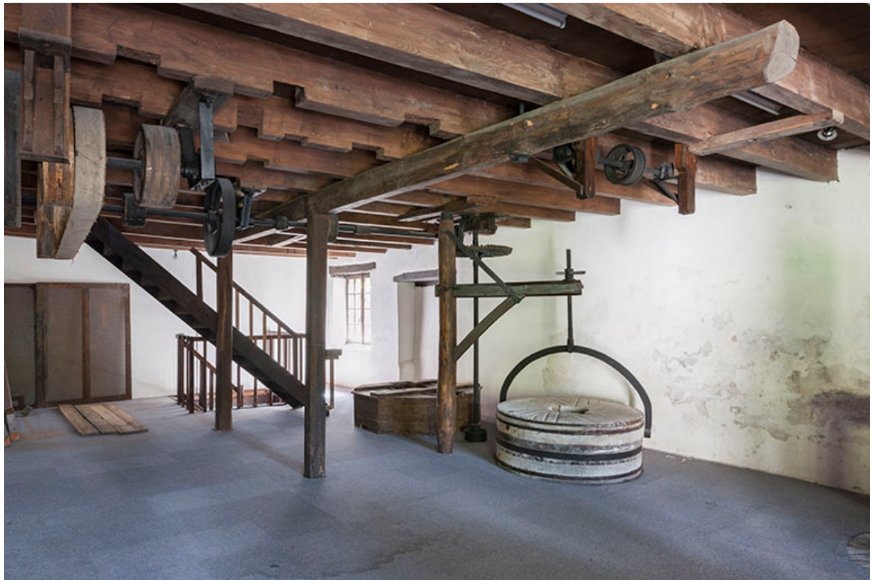
Premier étage. Vue d'ensemble depuis l'ouest.
