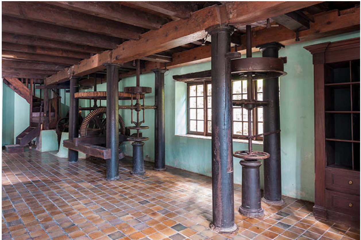
Rez-de-chaussée du moulin. Vue d'ensemble.
