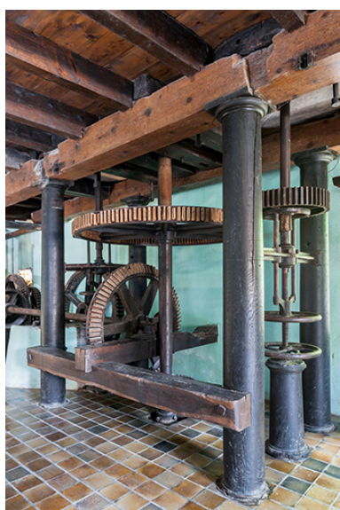
Beffroi (est) d'une paire de meules. Phot. Jérôme Mongreville IVR43_20152501746NUC4A
