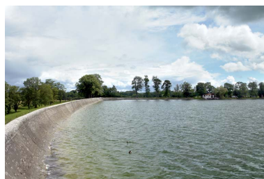
Vue de la digue principale. Phot. Alain Morelière IVR26_20072105873NUC2A
