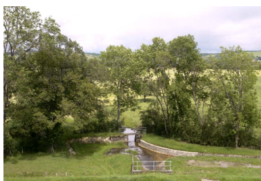
Décharge de fond au centre de la digue principale ; rigole. Jonction des eaux issues de cette décharge de fond et de celles du déversoir.
