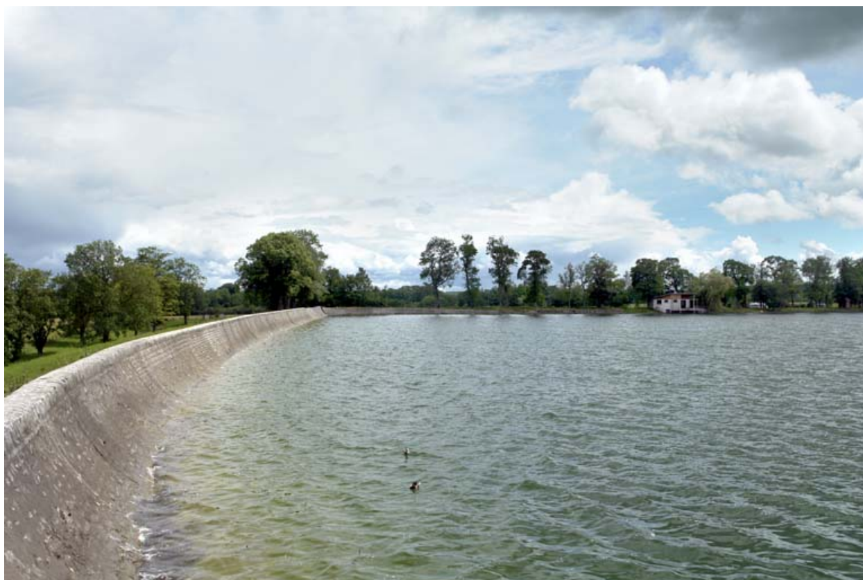
Vue de la digue principale.
