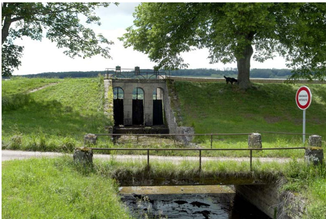
Déversoir ou "évacuateur de crue" à l'extrémité droite de la digue principale, commandé par trois vannes.
