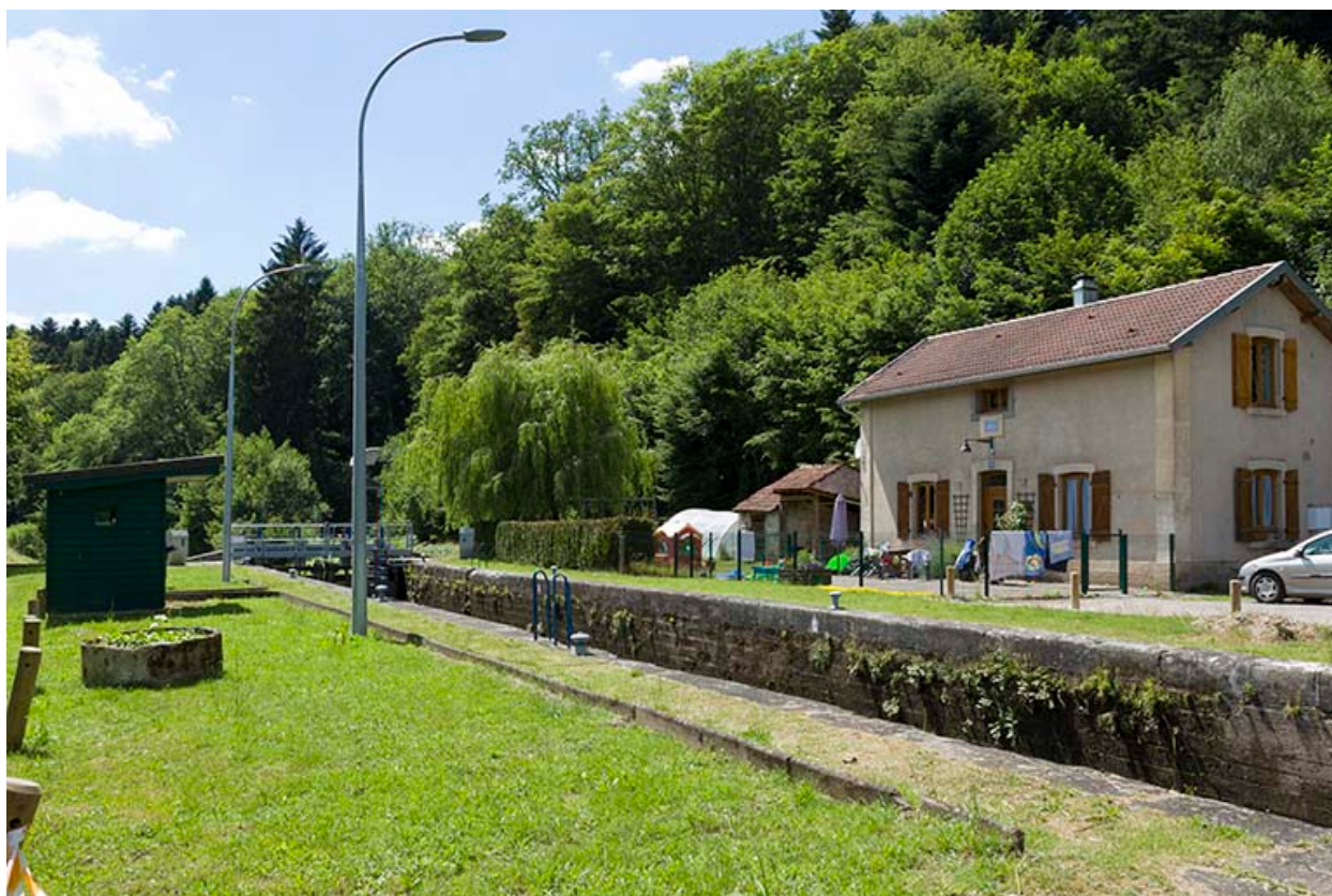
Le site d'écluse.
