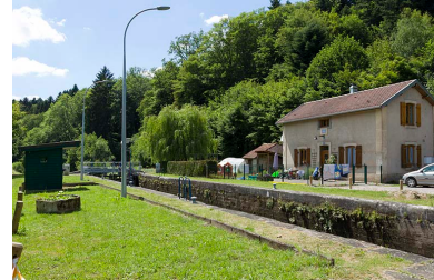
Le site d'écluse. Phot. Sonia Dourlot IVR43_20157000899NUC2A
