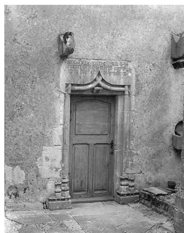
Porte de la chapelle gauche. Phot. Yves Sancey IVR43_19853900211X
