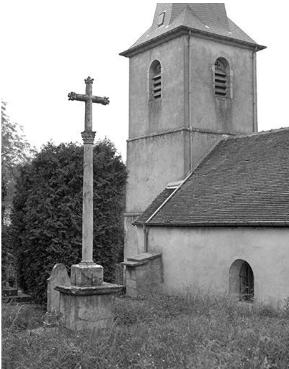
Tour-clocher et croix monumentale.
