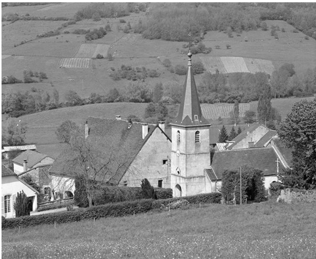
Façade antérieure et face droite.
