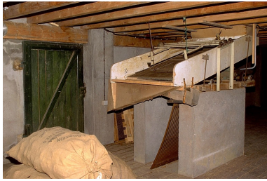
Vue d'ensemble. Phot. Jérôme Mongreville IVR43_19973900703ZA
