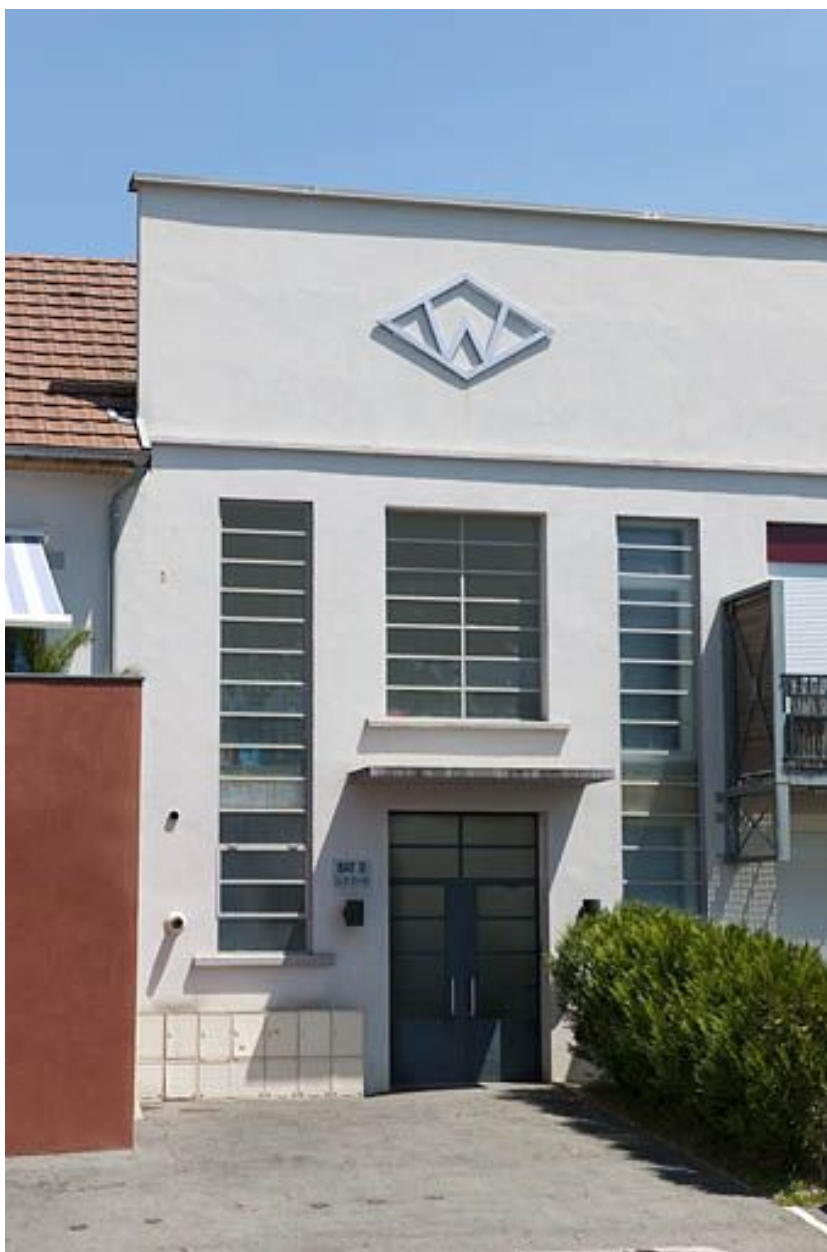
Détail de la façade occidentale.
