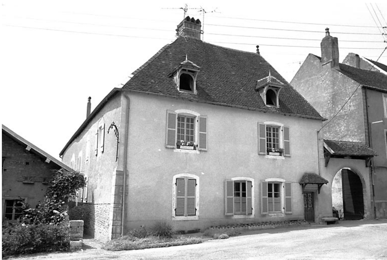
Vue d'ensemble de l'habitation depuis la rue.
