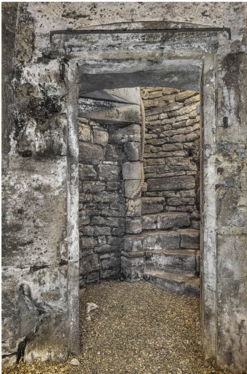
Première volée de l'escalier en vis.
