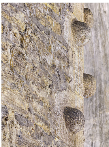
Détail du bossage (cave). Phot. Thierry Kuntz IVR26_20232100320NUC4A
