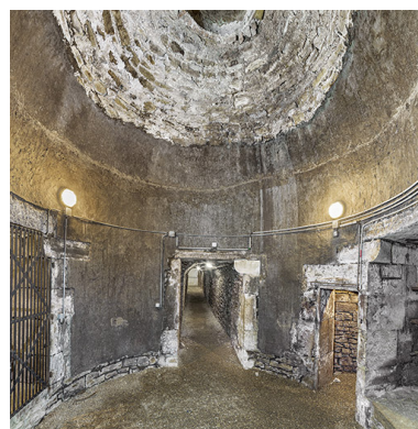
Niveau inférieur. Phot. Thierry Kuntz IVR26_20232100322NUC4A
