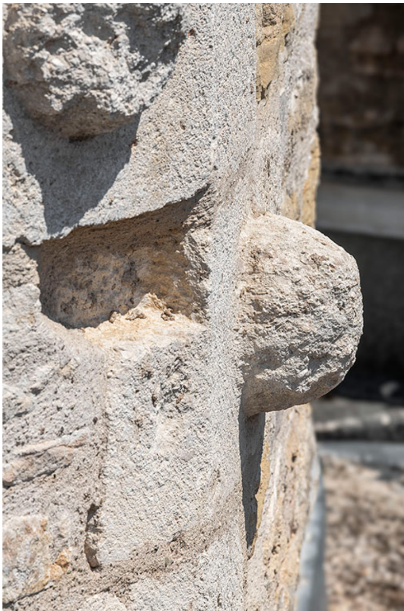
Détail du bossage (plateforme).
