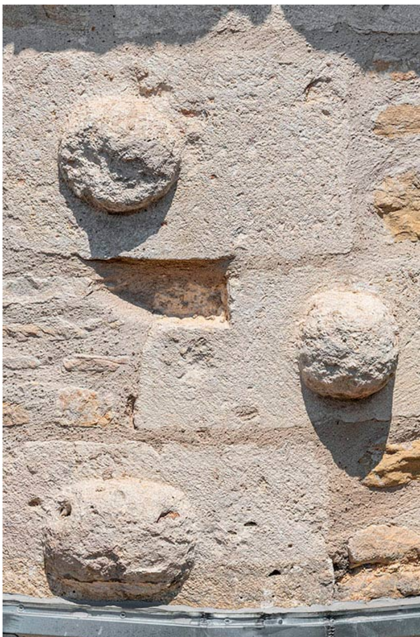
Bossage au niveau de la plateforme.
