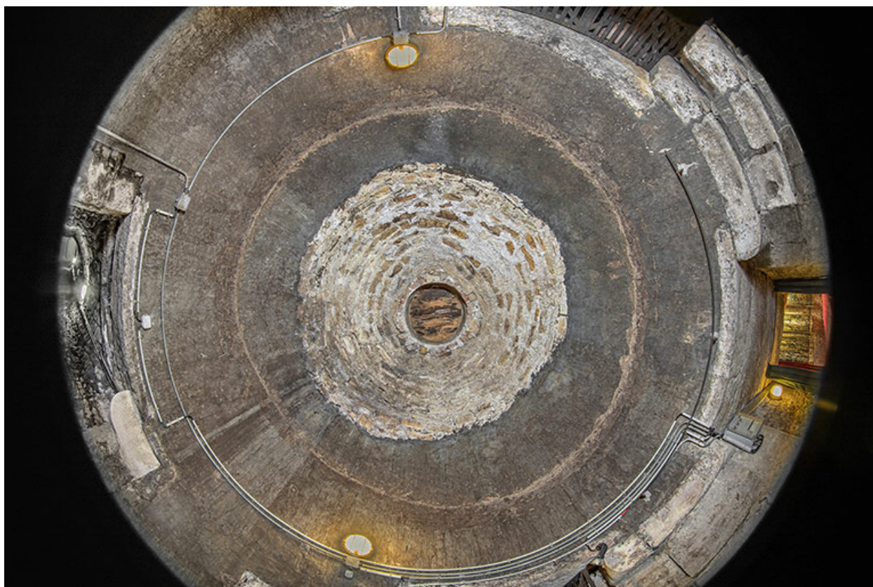
Plafond du niveau inférieur.
