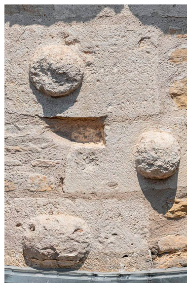
Bossage au niveau de la plateforme.
