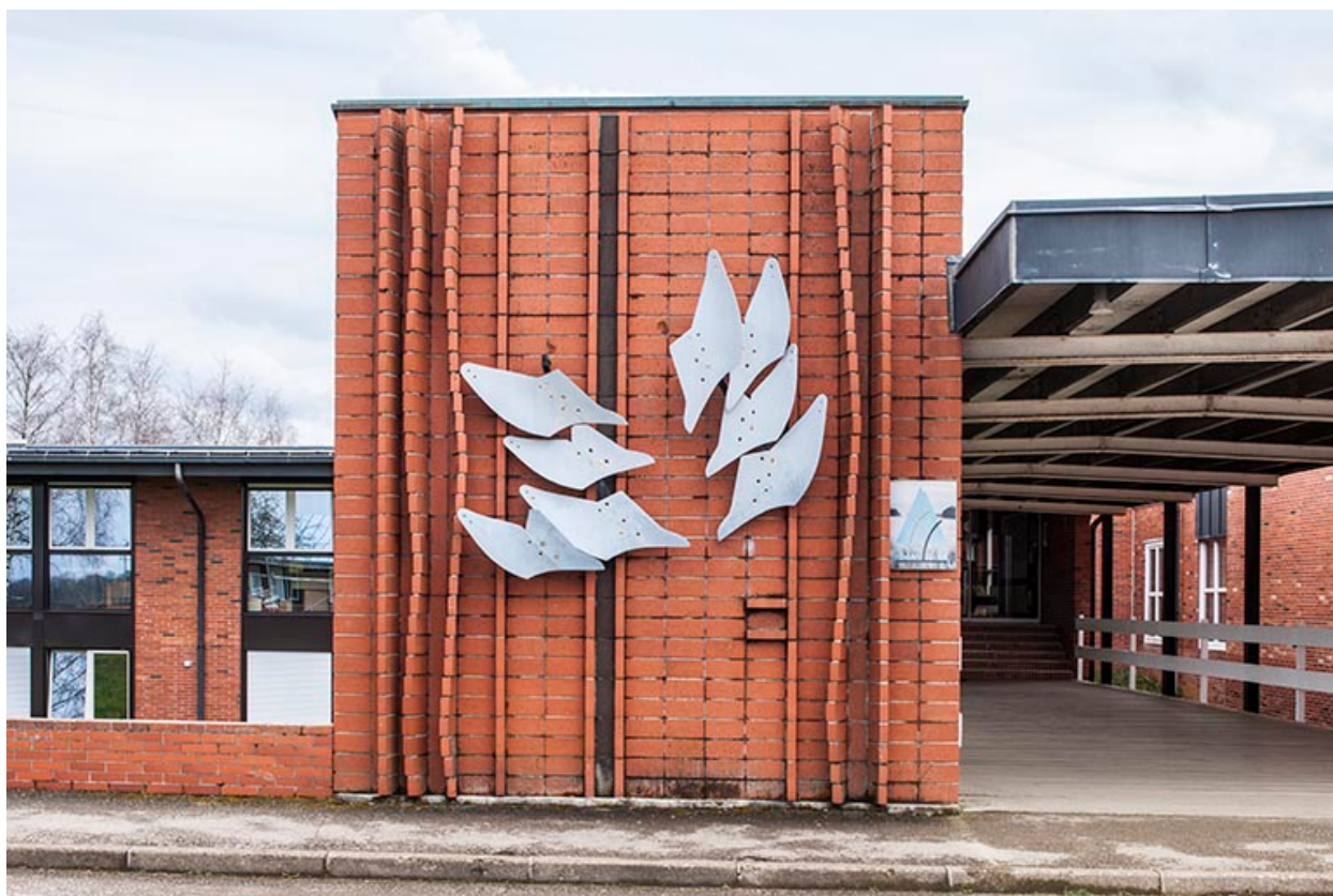
Mur nord vu de face.
