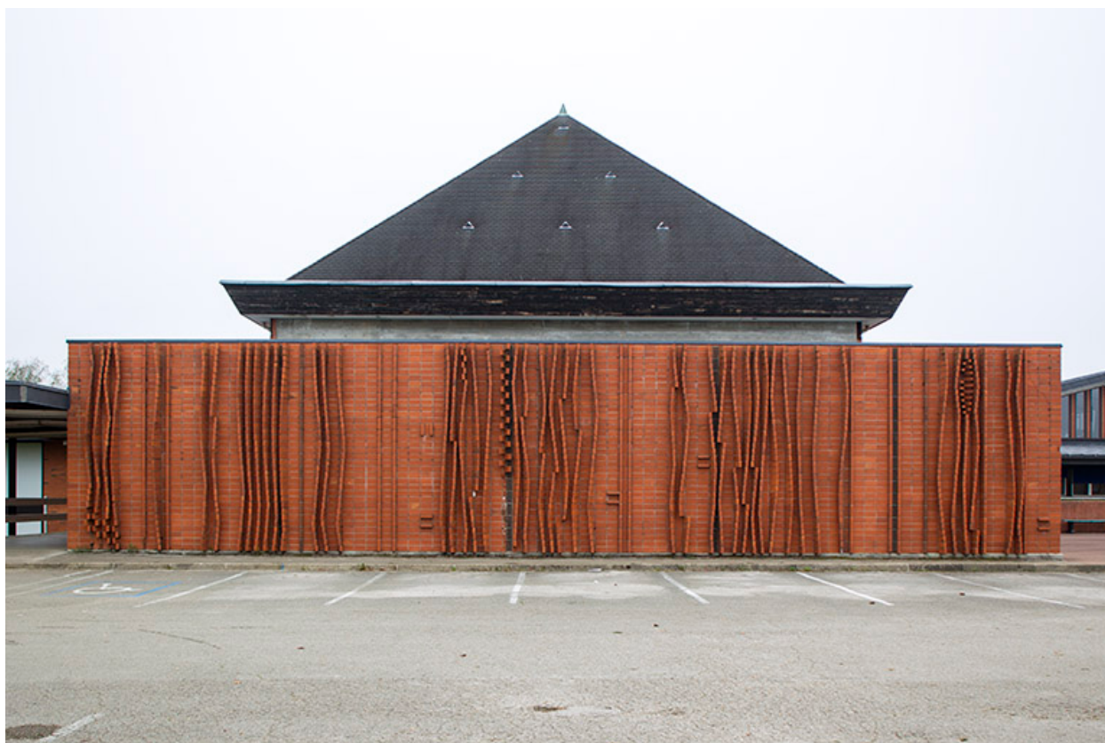
Vue de face du long mur sud.
