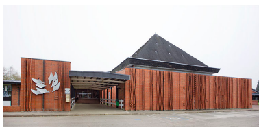
Vue d'ensemble de l'oeuvre de face. Phot. Sonia Dourlot IVR43_20143900818NUC2A
