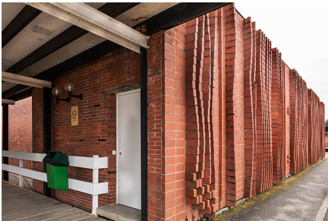
Mur sud vu de profil.
