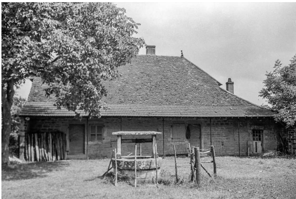
Bâtiment d'habitation : façade antérieure.
