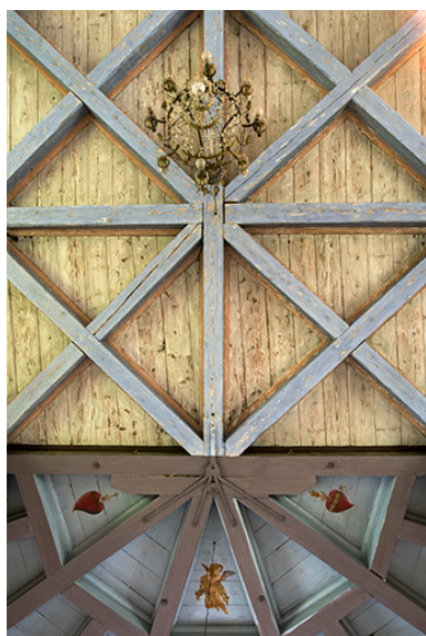
Détail du plafond. Phot. Sonia Dourlot IVR43_20157001179NUC4A
