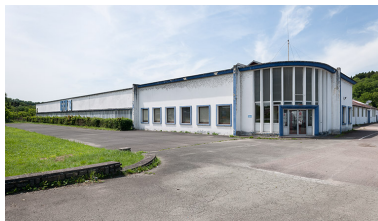
Façade est et entrée de l'usine. Phot. Jérôme Mongreville IVR43_20142501383NUC4A
