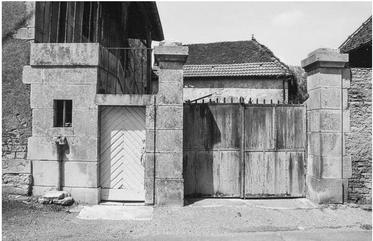
Vue rapprochée du portail d'entrée.
