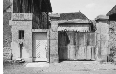
Vue rapprochée du portail d'entrée. Phot. Bernard Lardière IVR43_19817000195Z
