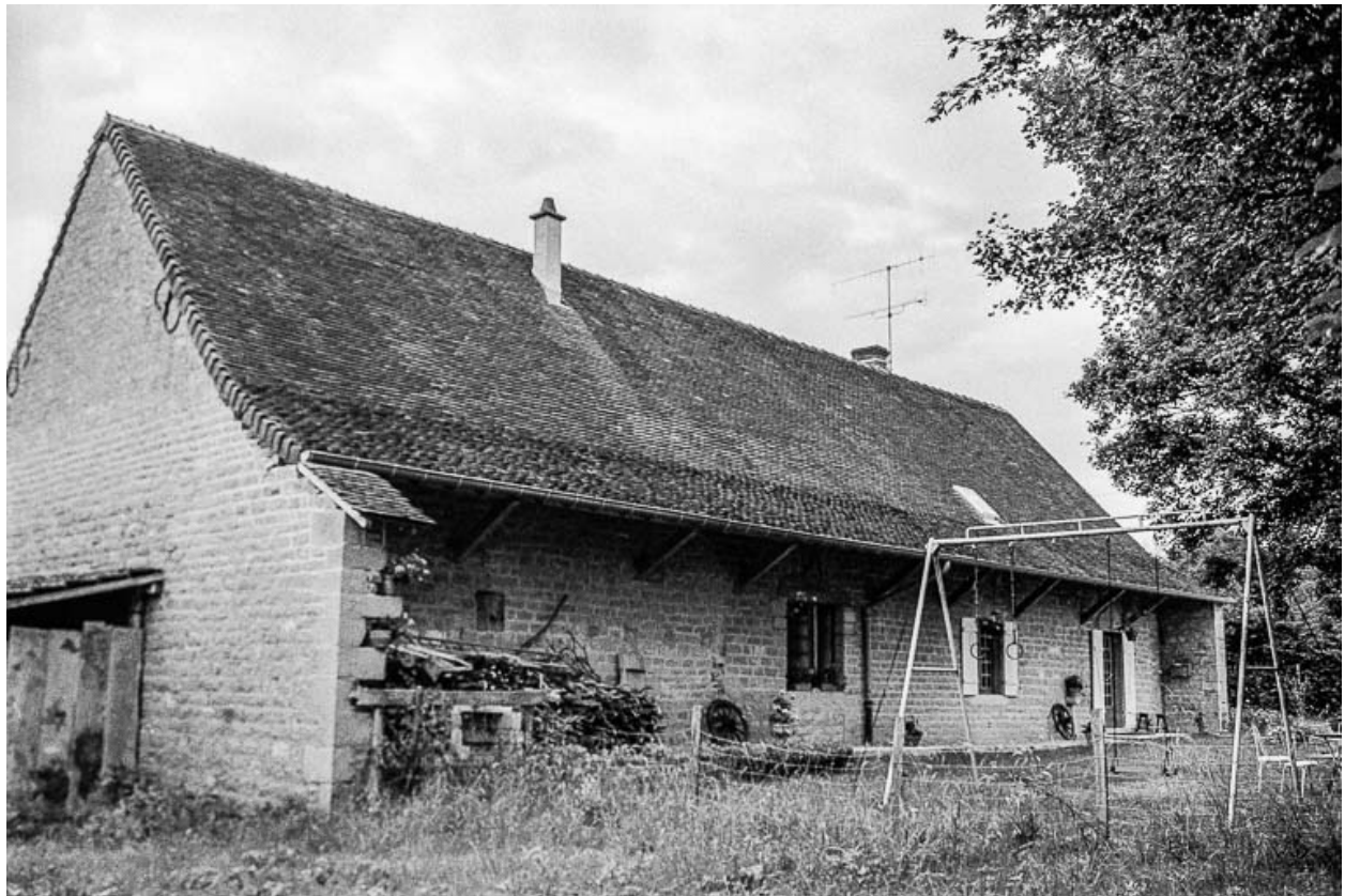
Ferme : façade postérieure.
