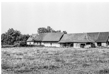
Ferme : vue générale. Phot. Guy Forestier IVR43_19753900366Z
