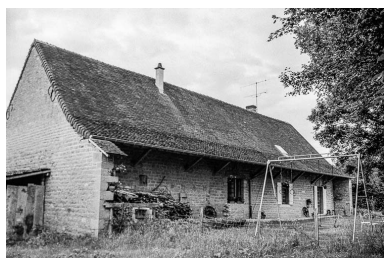
Ferme : façade postérieure. Phot. Guy Forestier IVR43_19753900360Z
