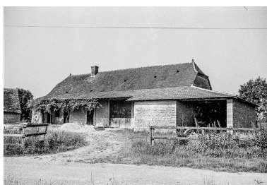
Ferme : vue générale. Phot. Guy Forestier IVR43_19753900362Z
