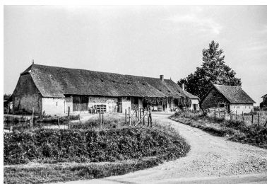
Ferme : vue générale. Phot. Guy Forestier IVR43_19753900365Z
