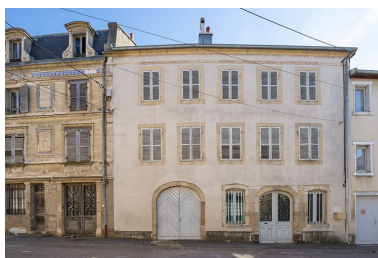
La façade antérieure. Phot. Jérôme Mongreville IVR43_20217000683NUC4A
