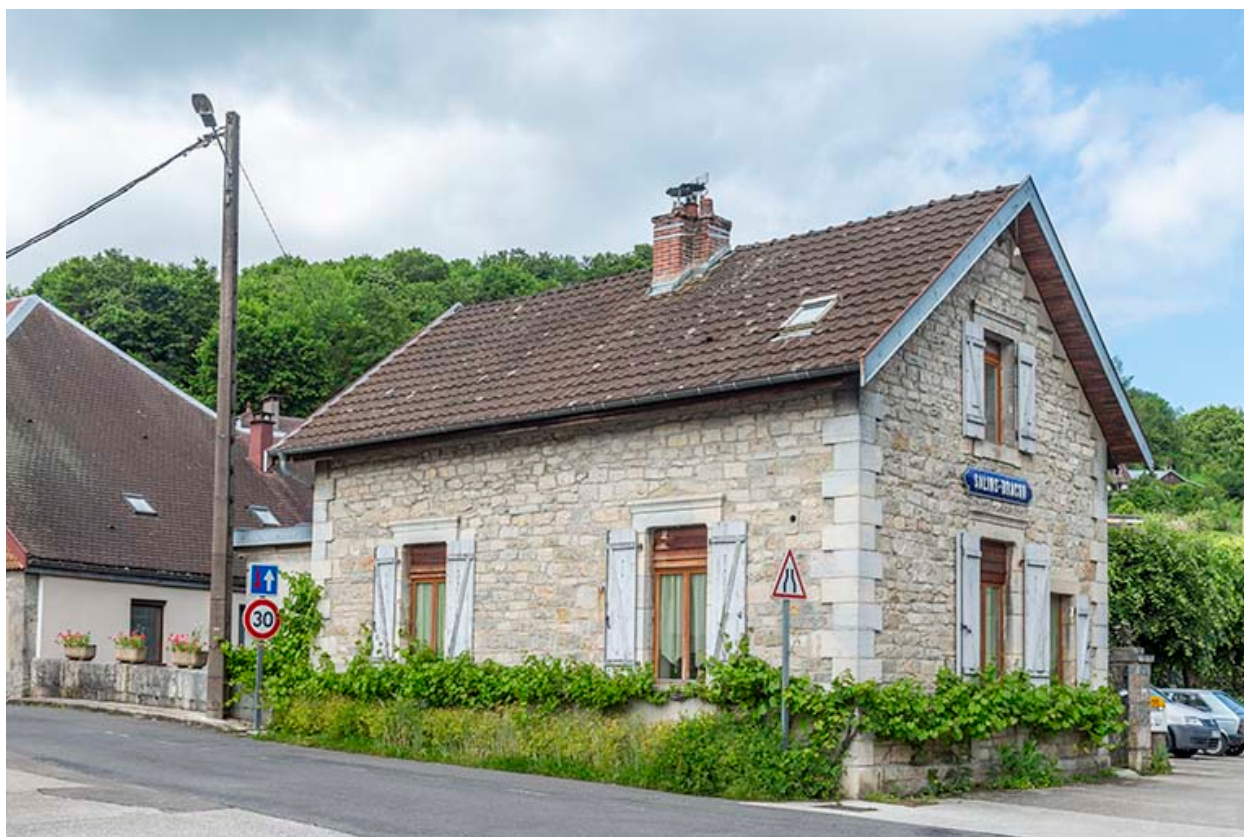
Vue depuis le sud-est.
