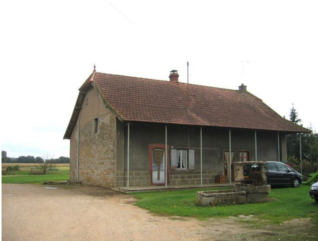
Vue d'ensemble de la façade de l'habitation.
