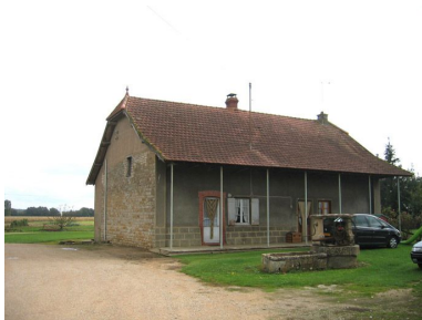
Vue d'ensemble de la façade de l'habitation.
