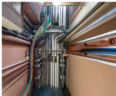
Salle des Assemblées : vue du système de rails pour faire coulisser manuellement la cloison. Phot. Pierre-Marie Barbe-Richaud IVR26_20142102182NUC2A
