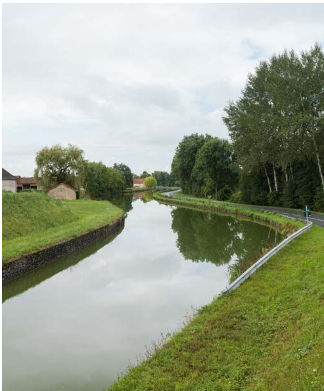
Vue d'ensemble du port.
