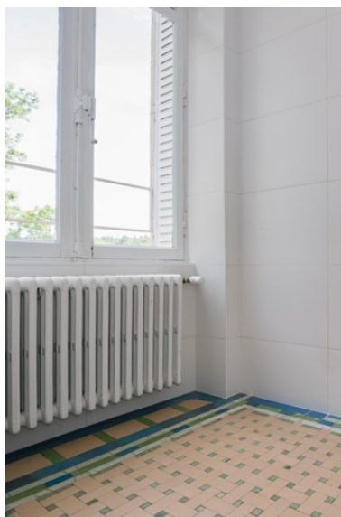
Vue d'un angle de la salle de bain. Phot. Pierre-Marie Barbe-Richaud IVR26_20195800585NUC4A
