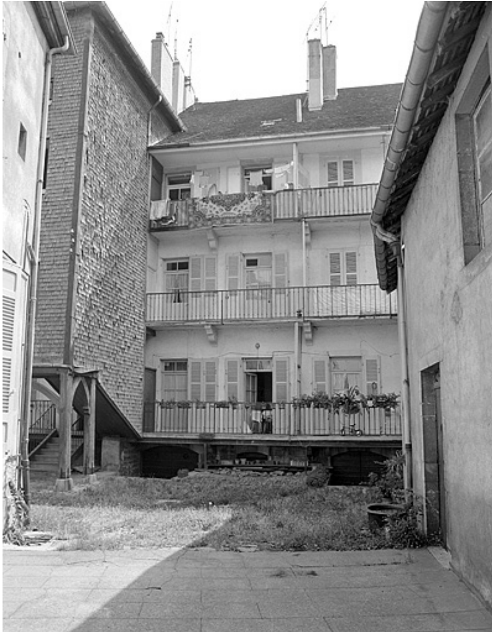
Façade postérieure montrant l'escalier à gauche.
