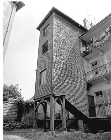
Escalier flanquant la façade postérieure. Phot. Yves Sancey IVR43_19833900238X
