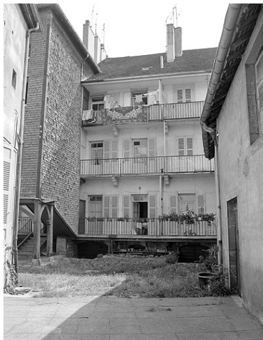
Façade postérieure montrant l'escalier à gauche. Phot. Yves Sancey IVR43_19833900326X
