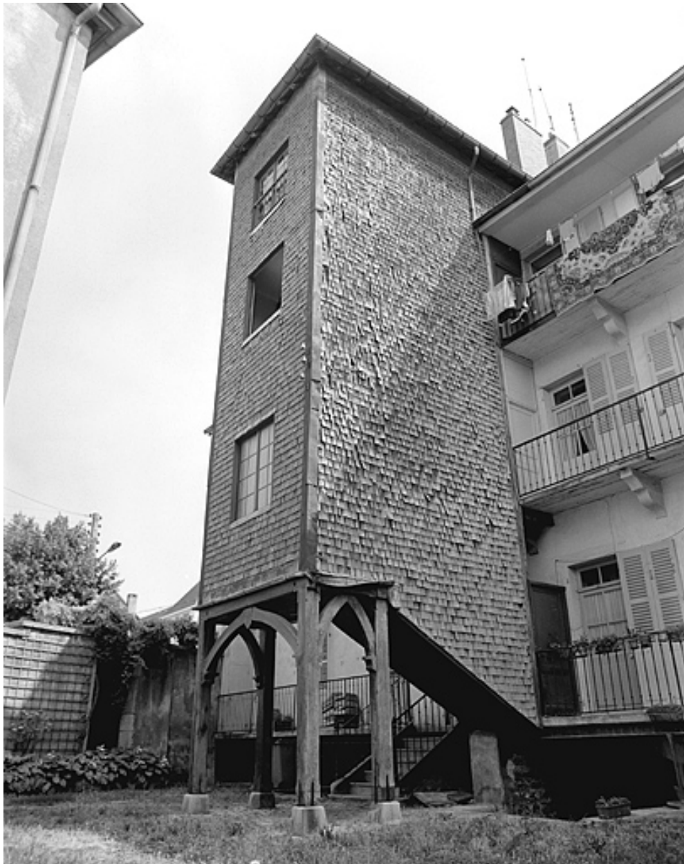
Escalier flanquant la façade postérieure.
