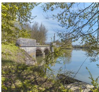
Le pont sur la Vouge (21). Phot. Thierry Kuntz IVR26_20162101428NUC4A
