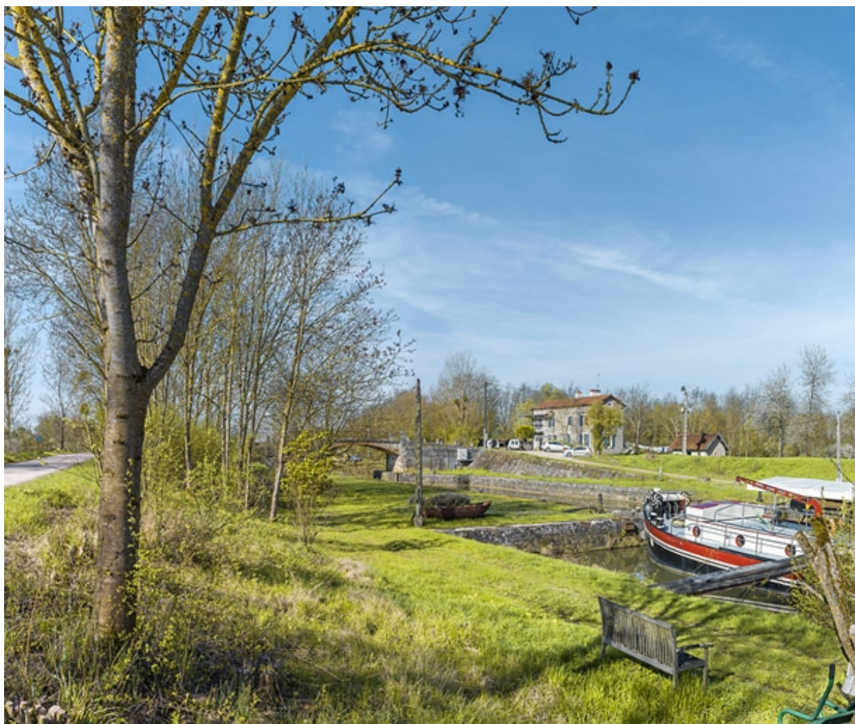
L'ancien site d'écluse de Saint-Jean-de-Losne (21).
