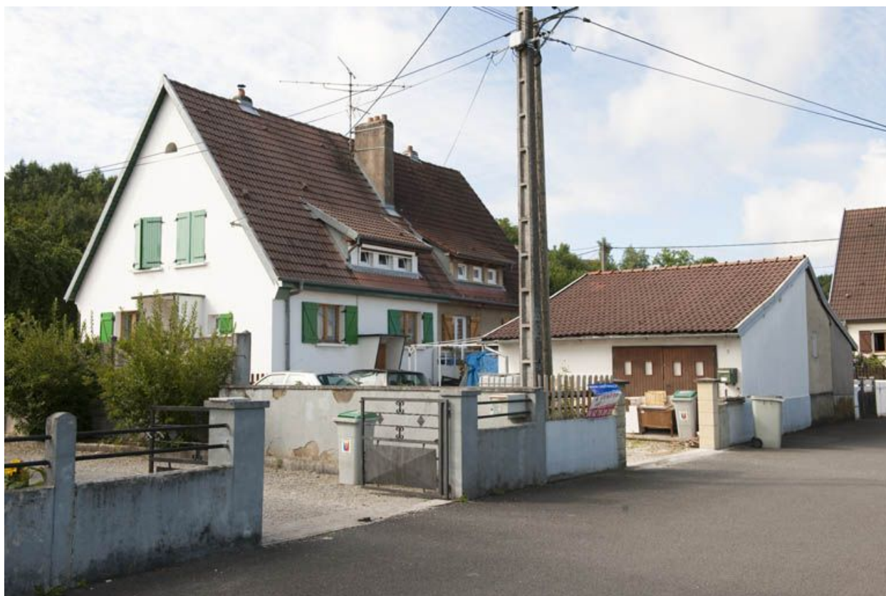
Maison et garage vus de trois quarts.
