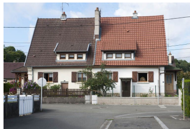
Façade antérieure d'une maison. Phot. Jérôme Mongreville IVR43_20112502175NUC4A
