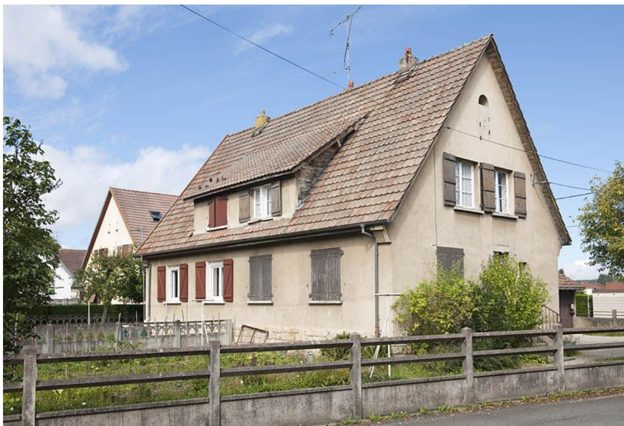
Vue de trois quarts d'une maison.
