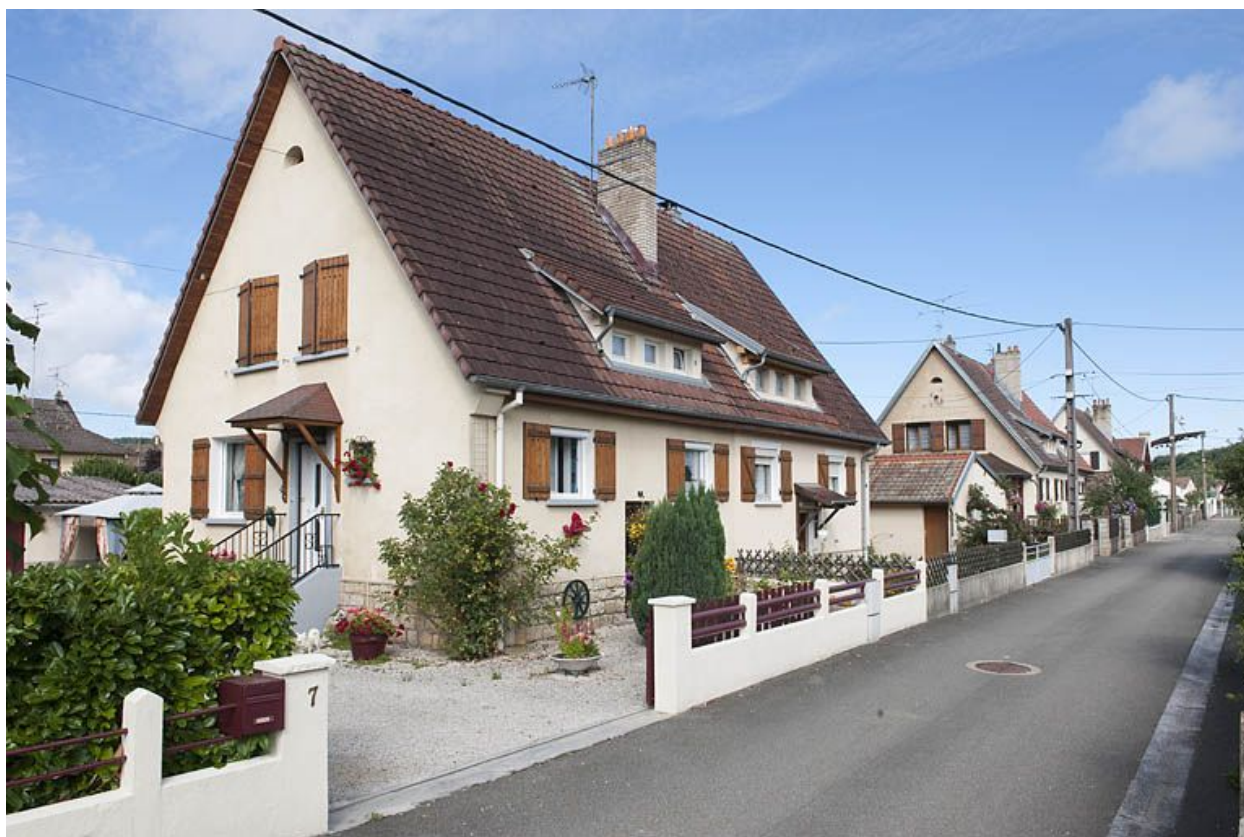
Vue d'ensemble d'une rue.
