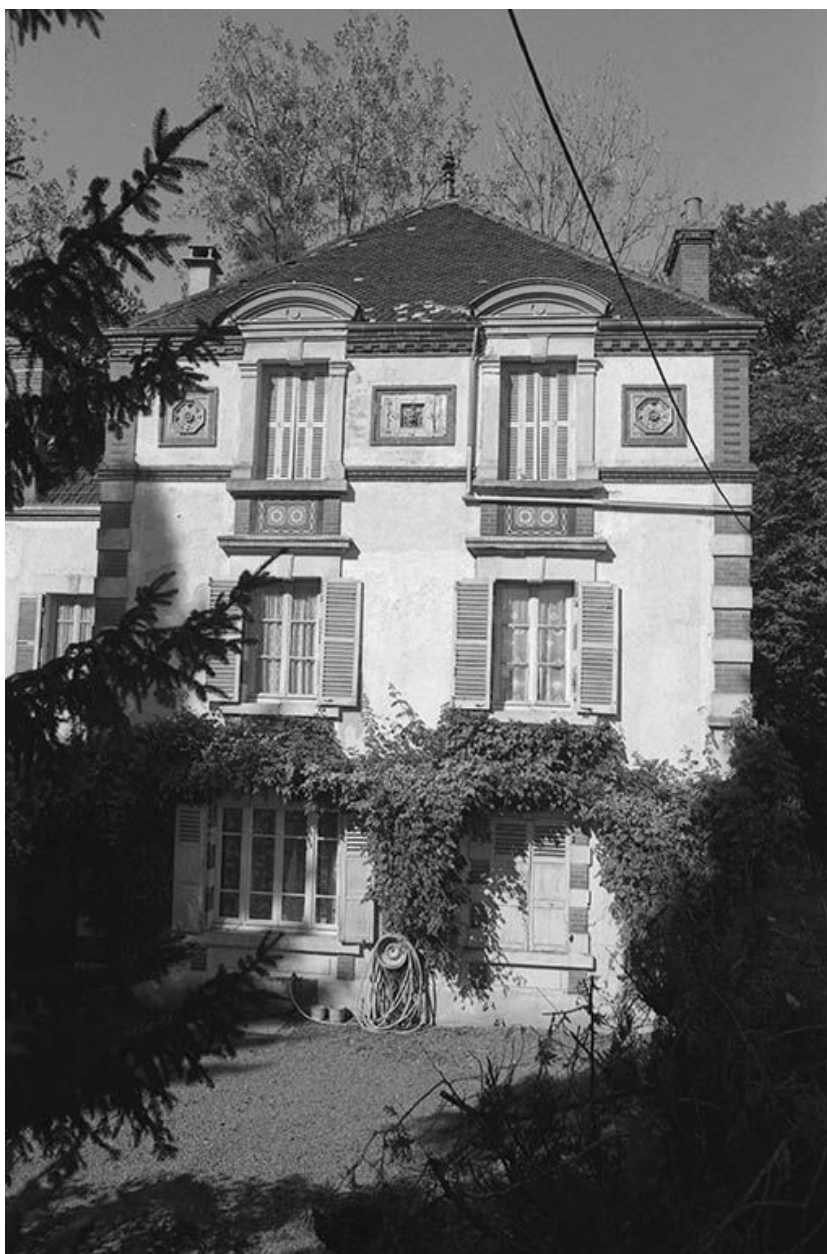
Façade sud du logement patronal.
