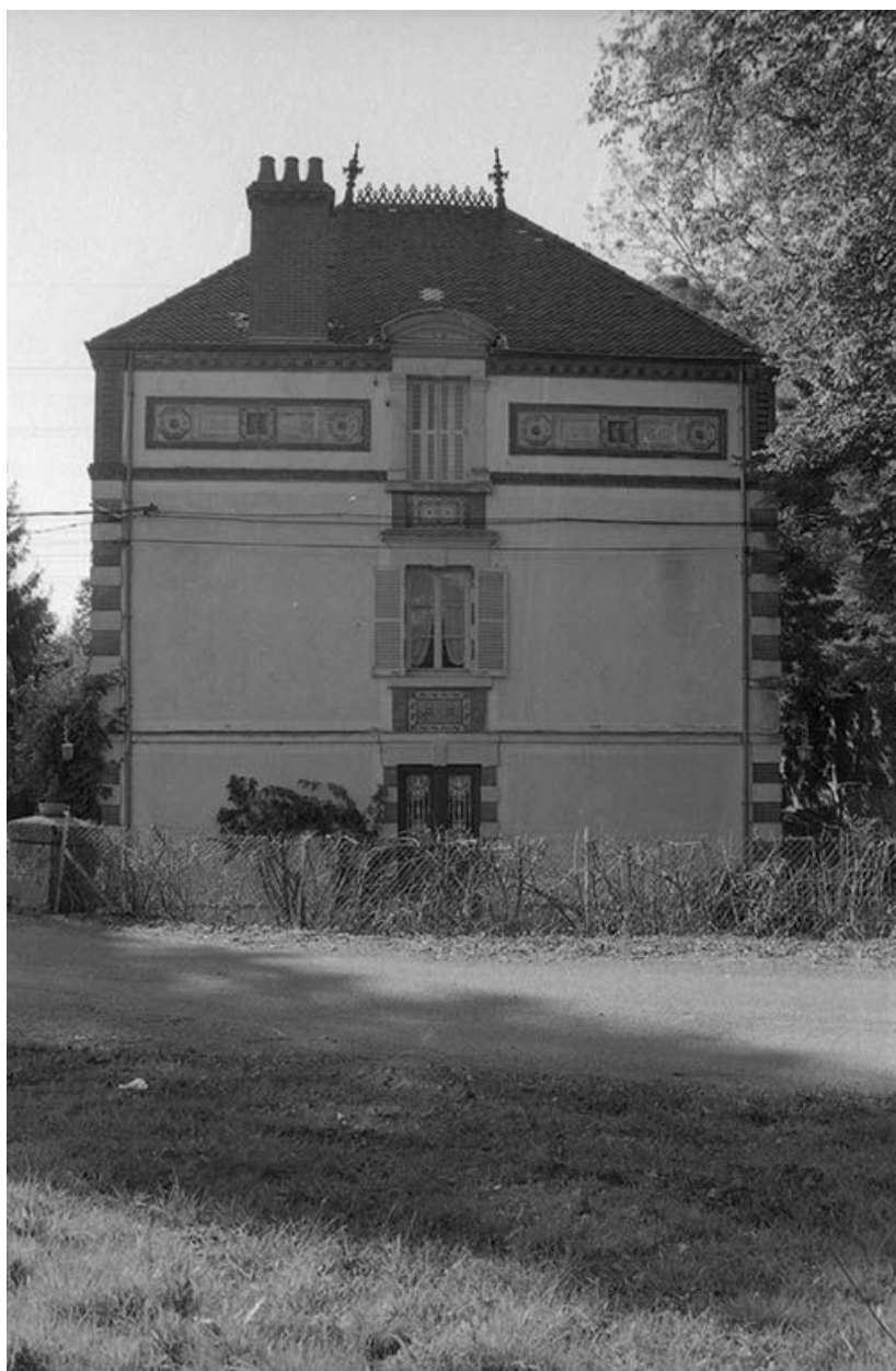
Façade est du logement patronal.
