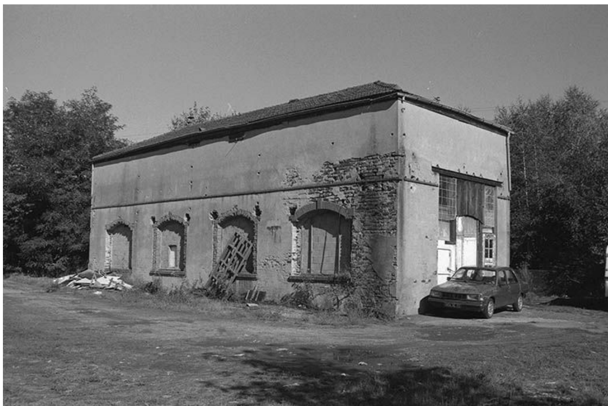
Salle des machines, vue du sud-ouest.
