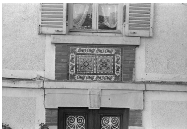
Détail de la façade est : allège de la baie du premier étage (carreaux de grès cérame produits par les Ets Perrusson d'Écuisses).
