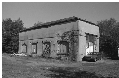
Salle des machines, vue du sud-ouest.
