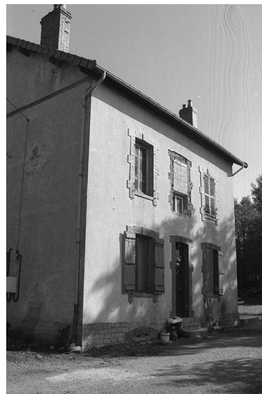
Logement d'ingénieur, vu du nord-est.
