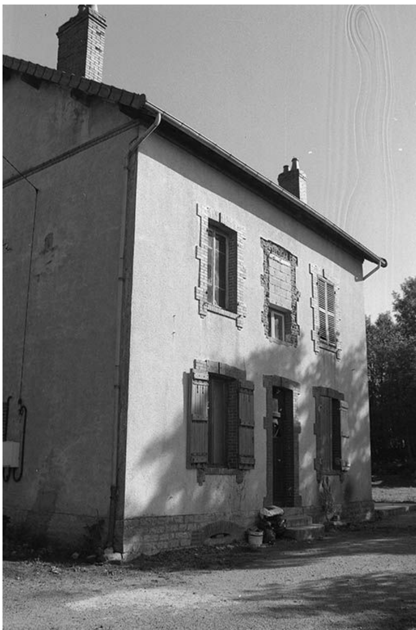
Logement d'ingénieur, vu du nord-est.
