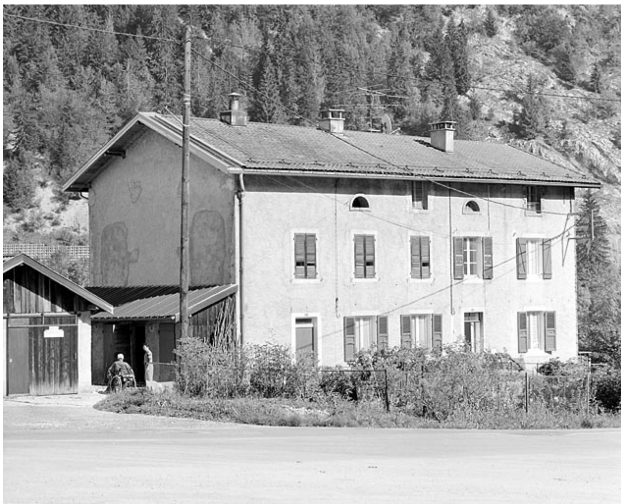
Façades antérieure et latérale gauche.
