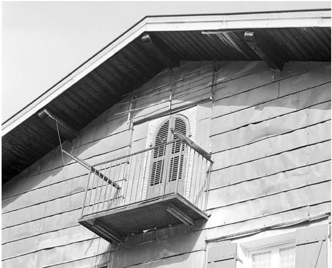
Façade latérale droite : porte haute et balcon.
