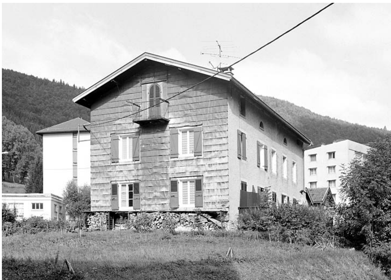
Façades postérieure et latérale droite.
