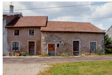
Façade antérieure. Phot. Yves Sancey IVR43_19993900337ZA
