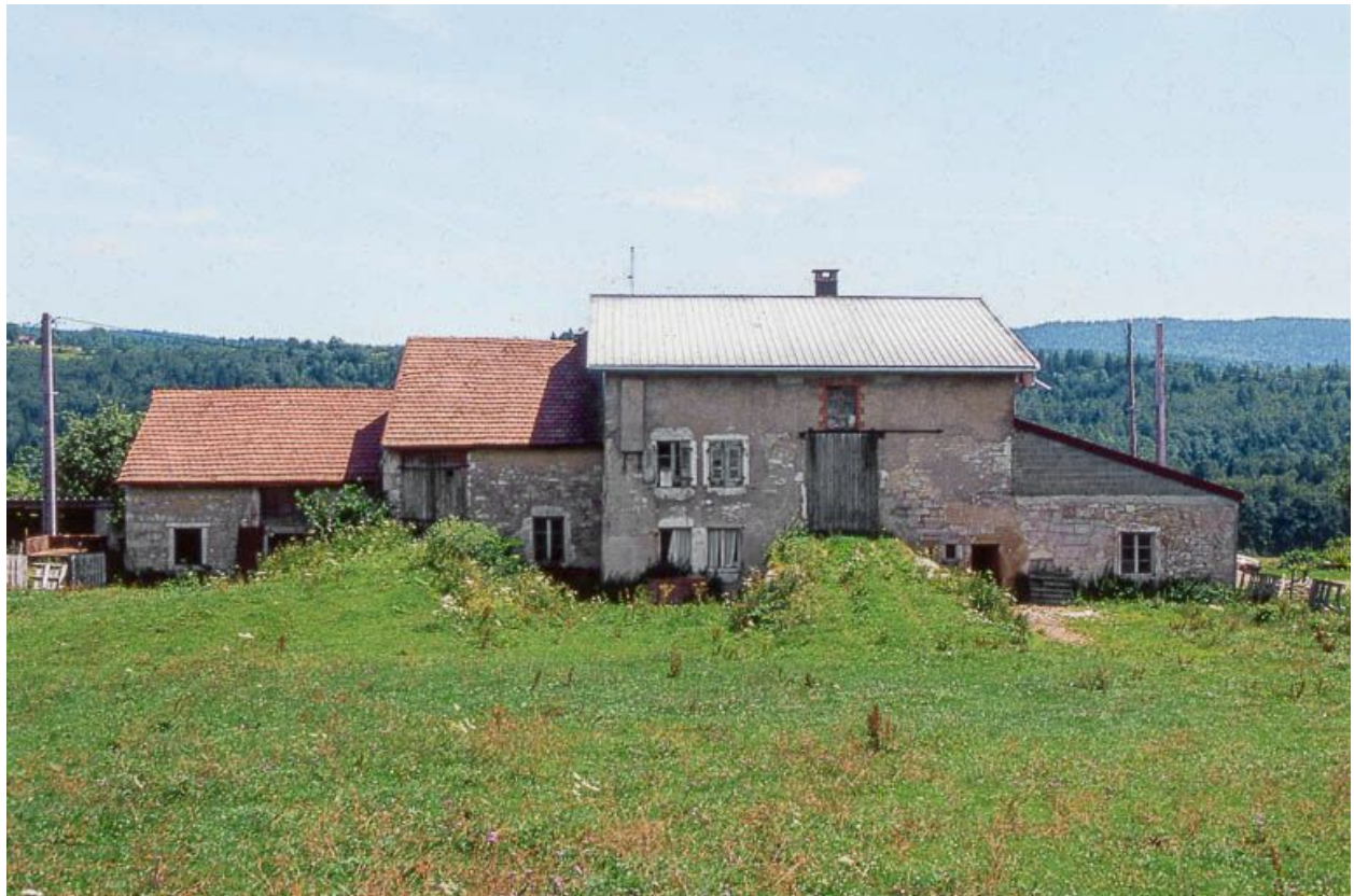
Vue éloignée de la façade postérieure.
