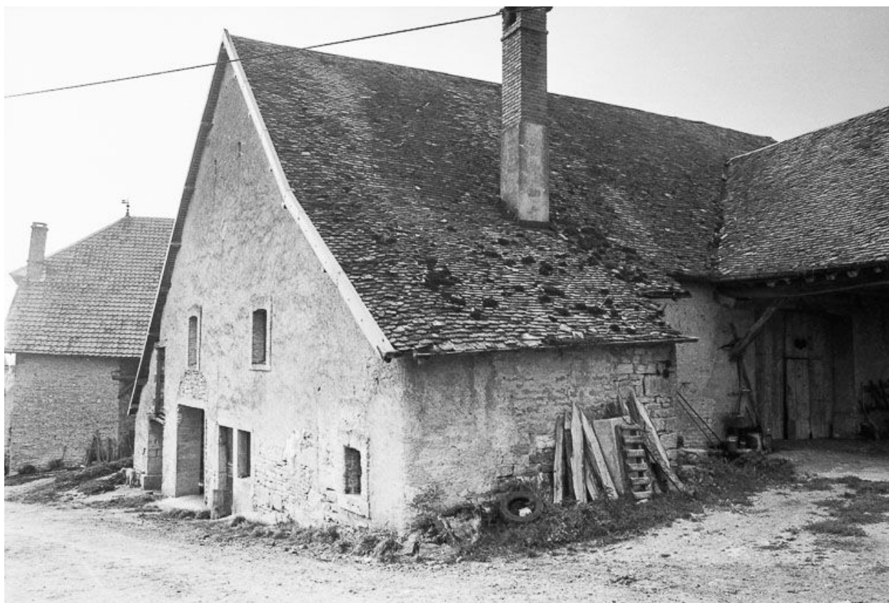
Ferme : vue de la partie habitation.
