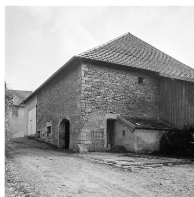
Ferme située rue du Lavoir : façade antérieure. La façade postérieure donne sur la place de l'Eglise. Phot. Liliane Hamelin IVR43_19762500951Z
