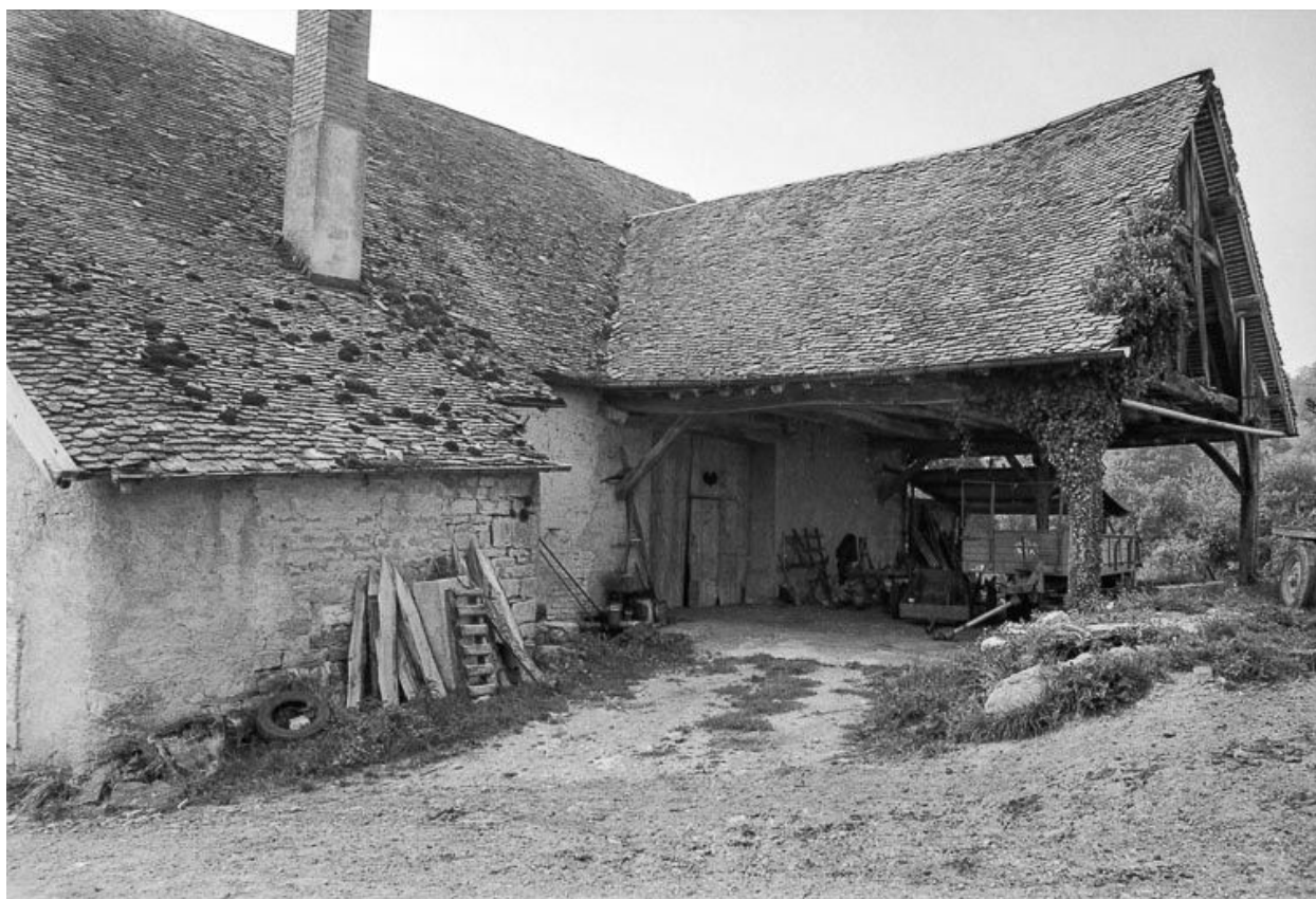
Ferme : vue de la partie agricole.
