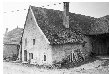
Ferme : vue de la partie habitation. Phot. Liliane Hamelin IVR43_19762500960Z
