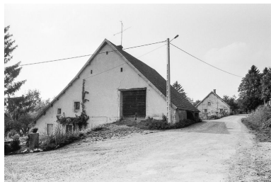
Ferme située rue de la Fontaine. Phot. Liliane Hamelin IVR43_19762500953Z
