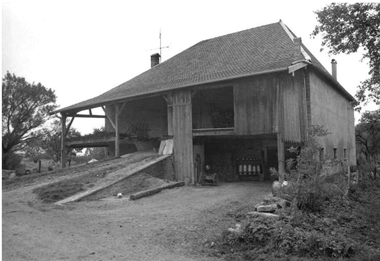
Ferme située rue du Grand Courtil.
