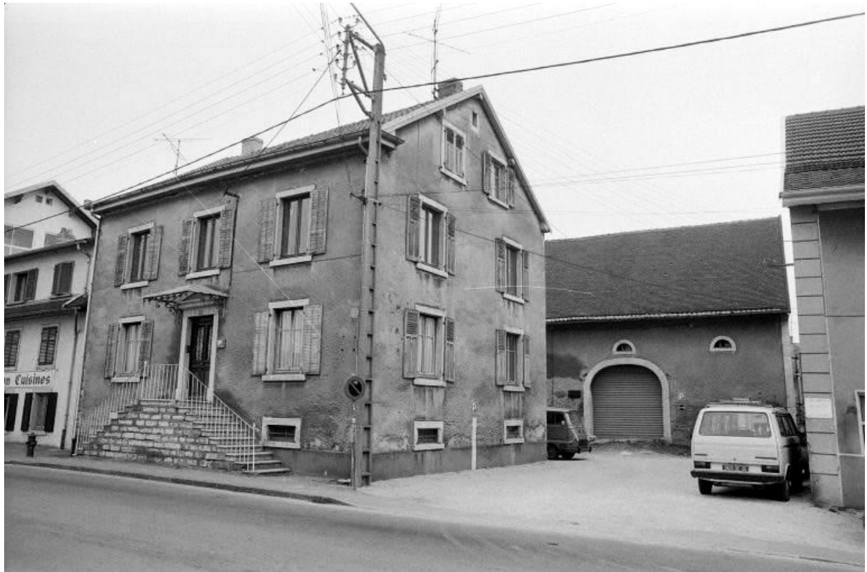
Maison située 16 rue de Belfort.
