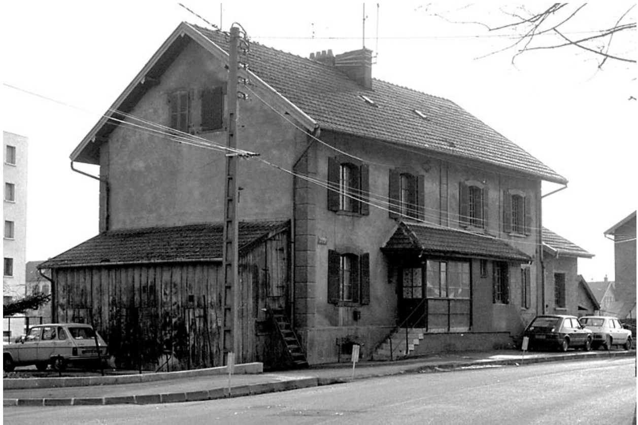
Maison située 197 rue de Mines.
