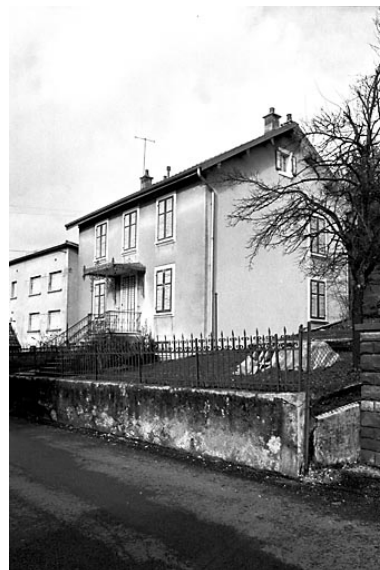
Maison située 13 rue sous les Vignes. Phot. Bernard Lardière IVR43_19832500193Z
