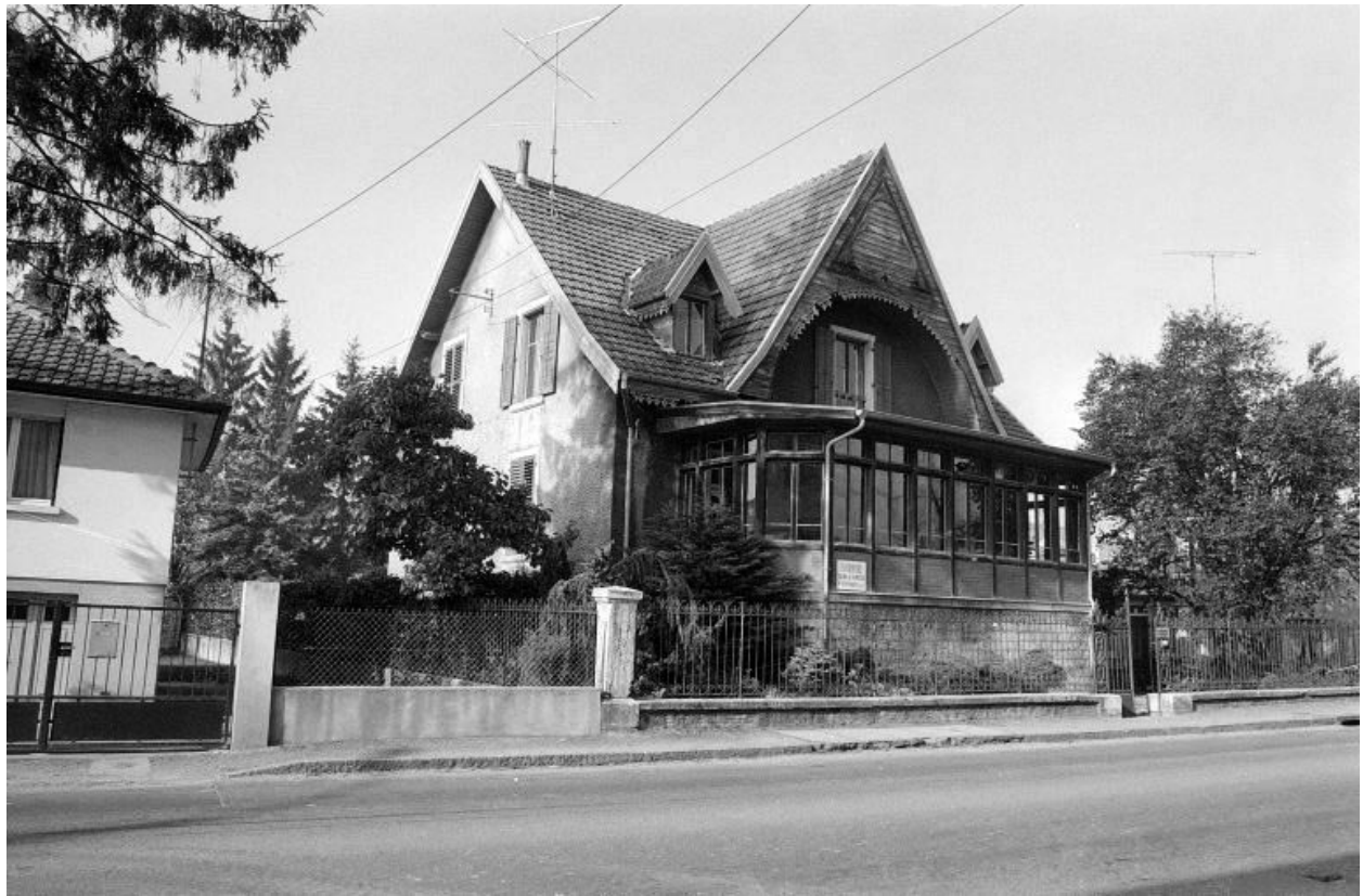
Maison située 27 rue de Belfort.
