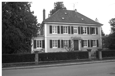
Maison située 3 rue de Valentigney. Phot. Bernard Lardière IVR43_19832500196Z
