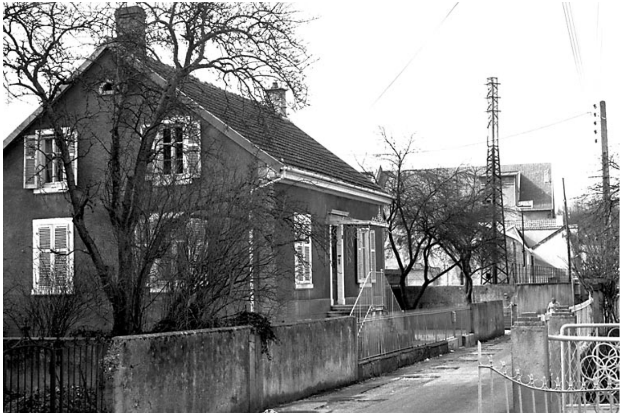
Maison située 5 rue des Serruriers.
