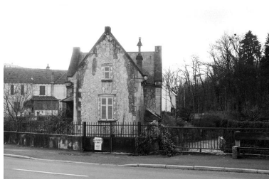
Maison située 68 rue de Valentigney. Phot. Bernard Lardière IVR43_19832500257Z
