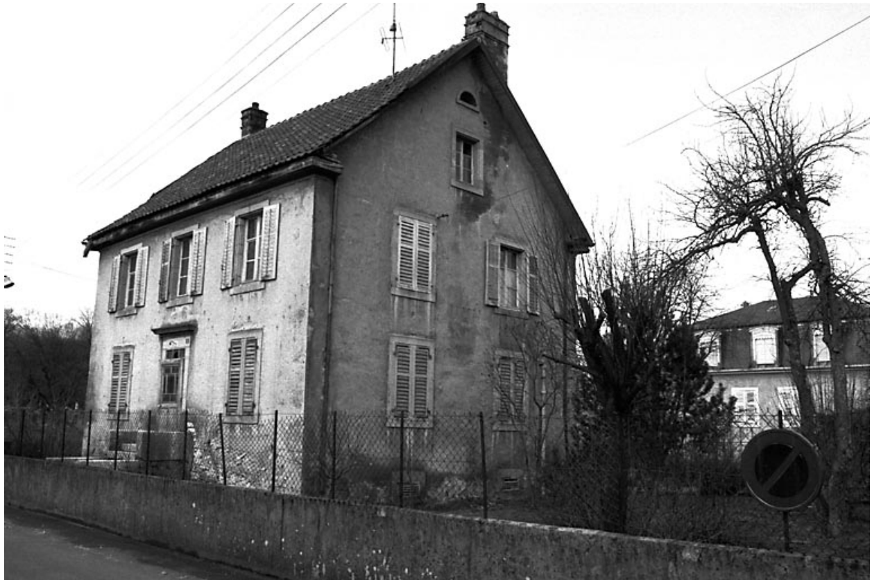
Maison située 8 rue des Serruriers.
