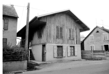
Maison située 7 rue des Prés. Phot. Bernard Lardière IVR43_19832500219Z
