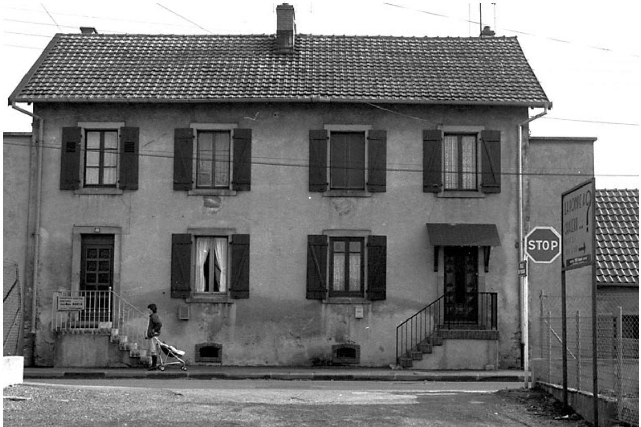
Maison située 189 rue des Mines.
