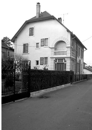
Maison située 6 rue du 11 Novembre. Phot. Bernard Lardière IVR43_19832500249Z
