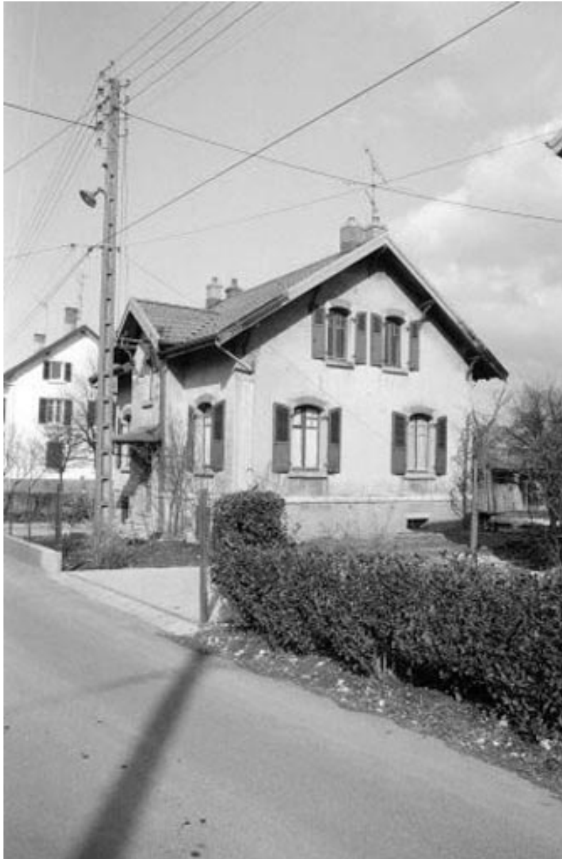
Maison située 15 rue des Arbues.
