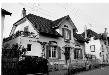
Maison située 22 rue Romaine. Phot. Bernard Lardière IVR43_19832500246Z
