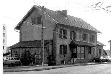
Maison située 197 rue de Mines. Phot. Bernard Lardière IVR43_19832500281Z
