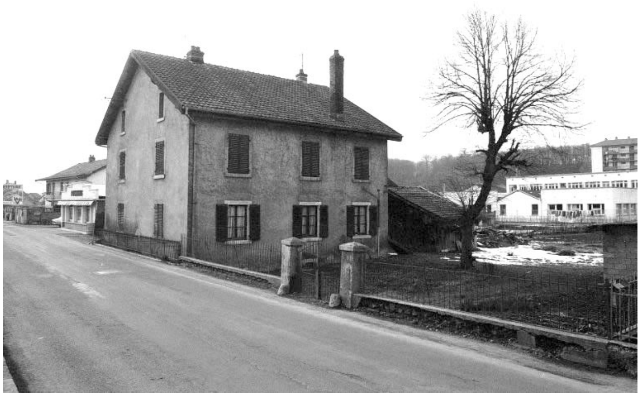
Maison située 124 rue des Mines.
