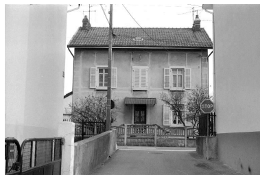
Maison située rue Romaine. Phot. Bernard Lardière IVR43_19832500289Z
