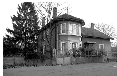
Maison située 11 rue Romaine. Phot. Bernard Lardière IVR43_19832500201Z
