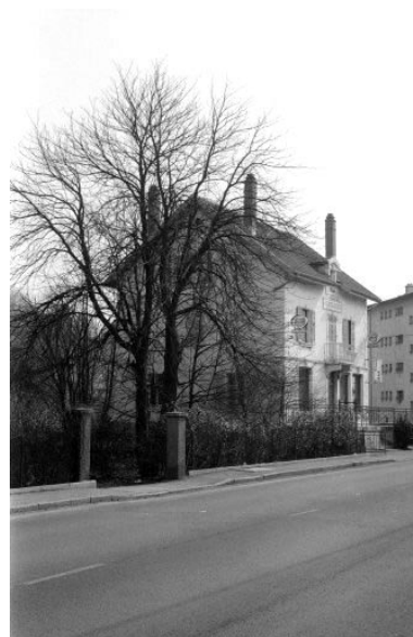
Vue de trois quarts gauche. Phot. Bernard Lardière IVR43_19832500180Z
