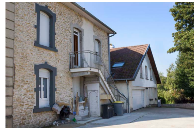
Logement : façade latérale droite. Phot. Yves Sancey IVR43_20132501777NUC2A
