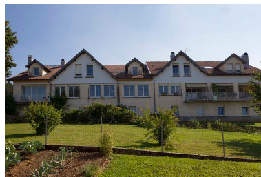
Ateliers de fabrication : façade postérieure. Phot. Yves Sancey IVR43_20132501779NUC2A
