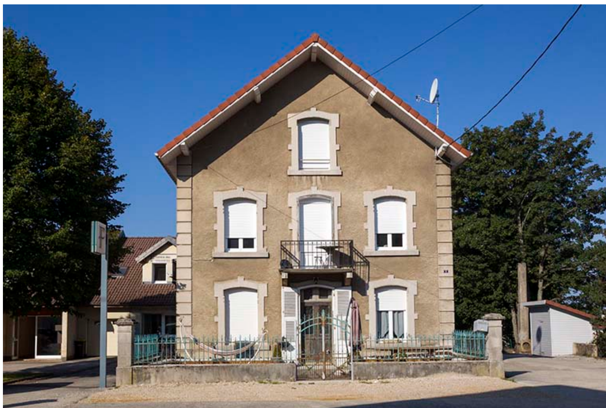
Logement : façade antérieure.
