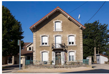
Logement : façade antérieure. Phot. Yves Sancey IVR43_20132501776NUC2A
