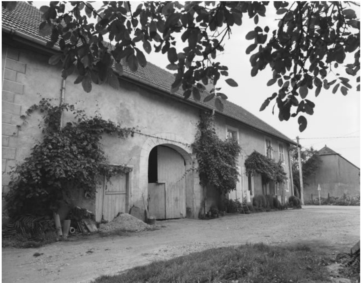
Vue d'ensemble de la façade antérieure.
