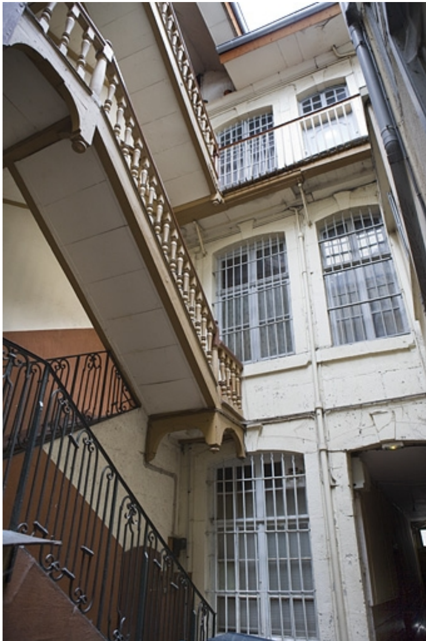
Façade postérieure du logis principal.
