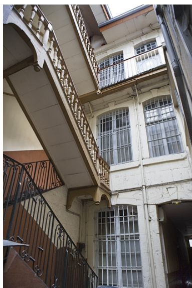
Façade postérieure du logis principal.
