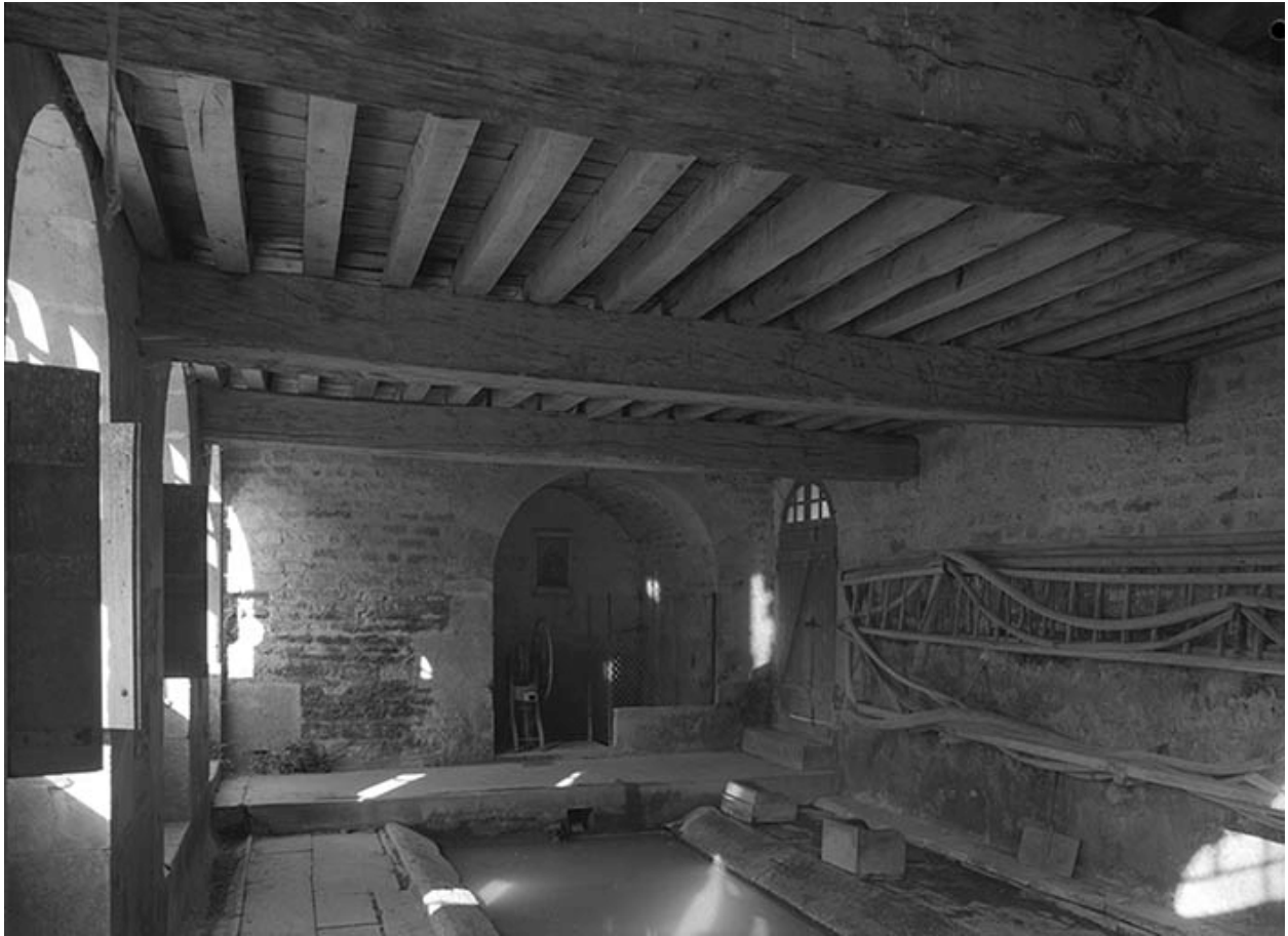
Vue intérieure. Lavoir.
