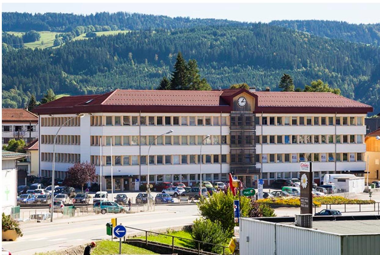
Usine : façades antérieure et latérale gauche.
