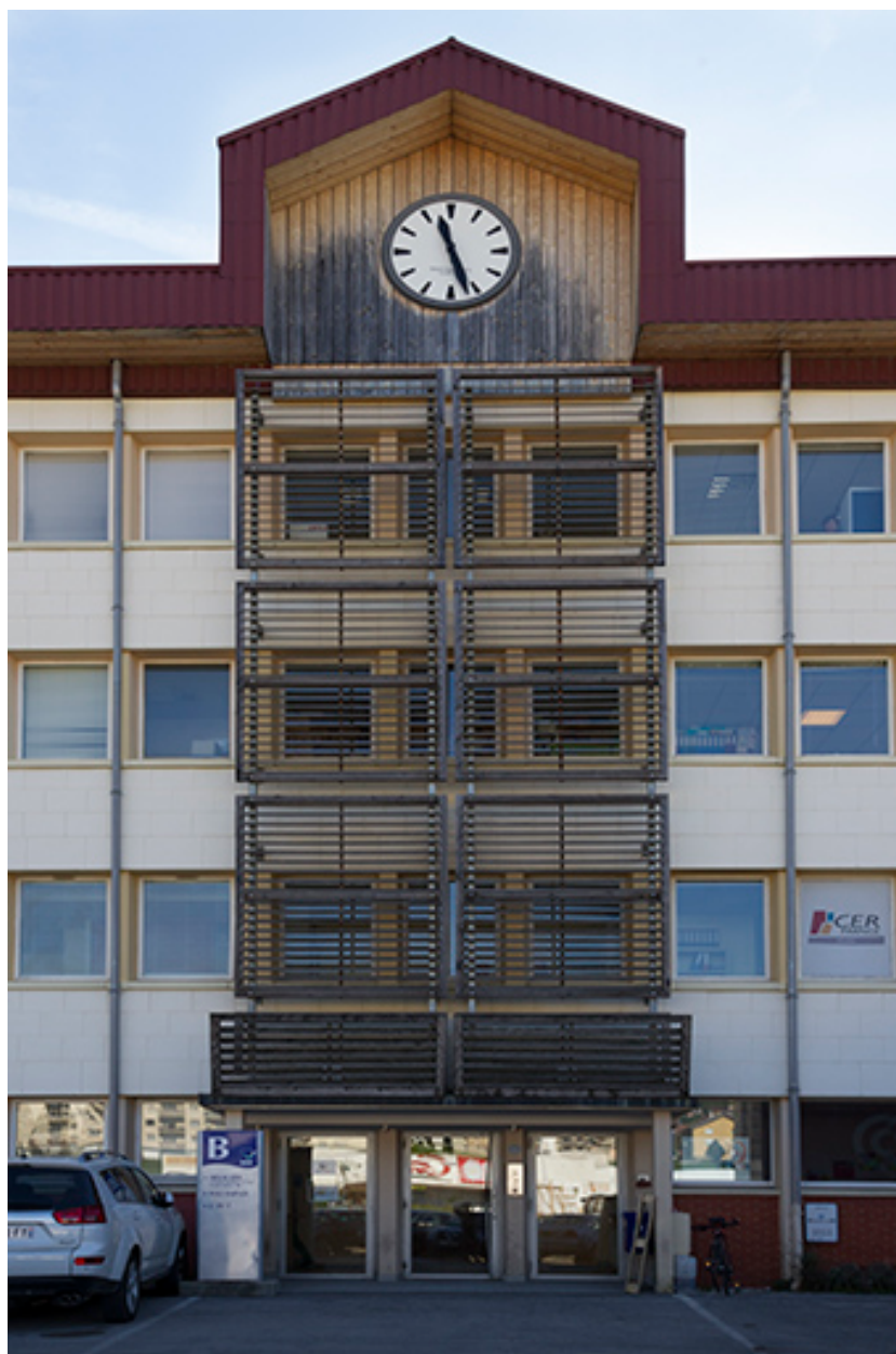
Usine : travées centrales de la façade antérieure.
