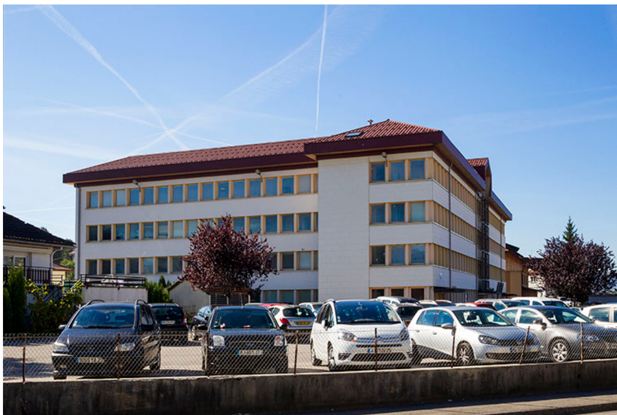
Usine : façade latérale gauche, de trois quarts.
