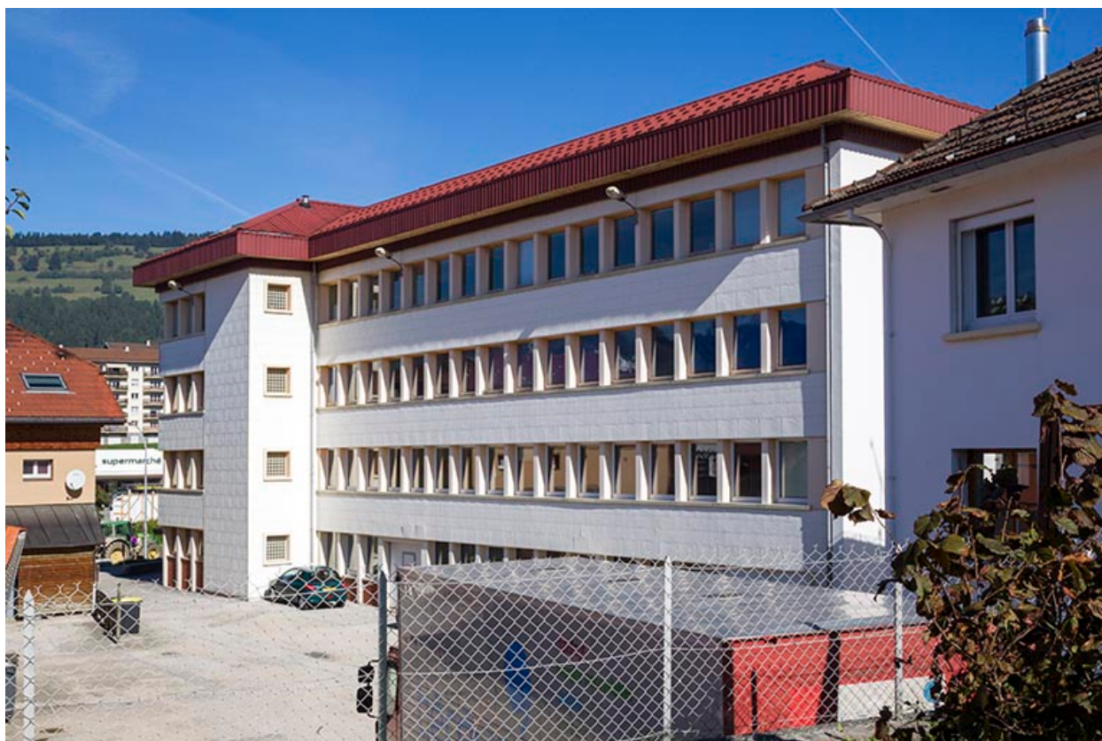
Usine : façade latérale droite, vue en enfilade.
