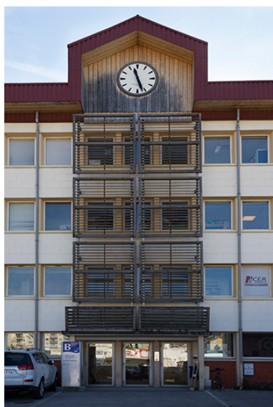
Usine : travées centrales de la façade antérieure. Phot. Yves Sancey IVR43_20132502197NUC2A
