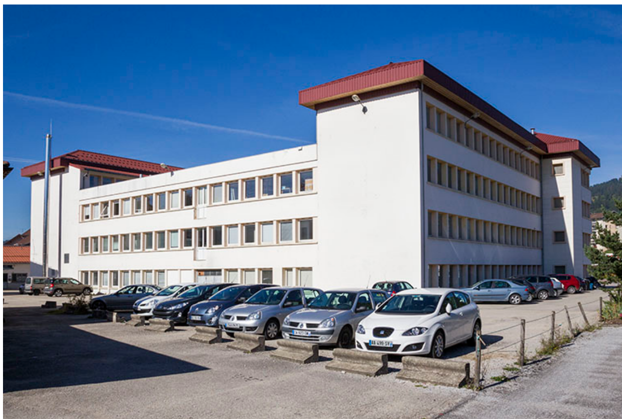
Usine : façades postérieure et latérale gauche.
