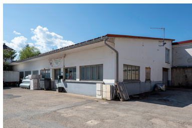
Bâtiment de 1981. Phot. Sonia Dourlot IVR43_20182501224NUC4A
