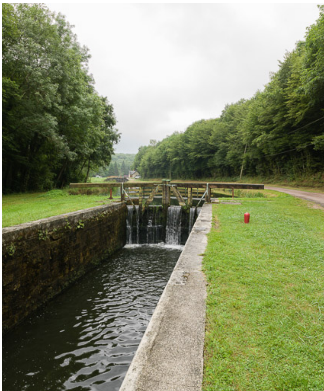
Vue du sas et du déversoir.
