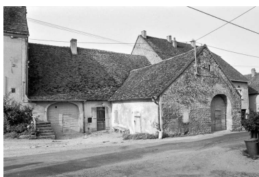
Ferme cadastrée AD 327 : façades antérieures. Phot. Bernard Pontefract IVR43_19763900306Z
