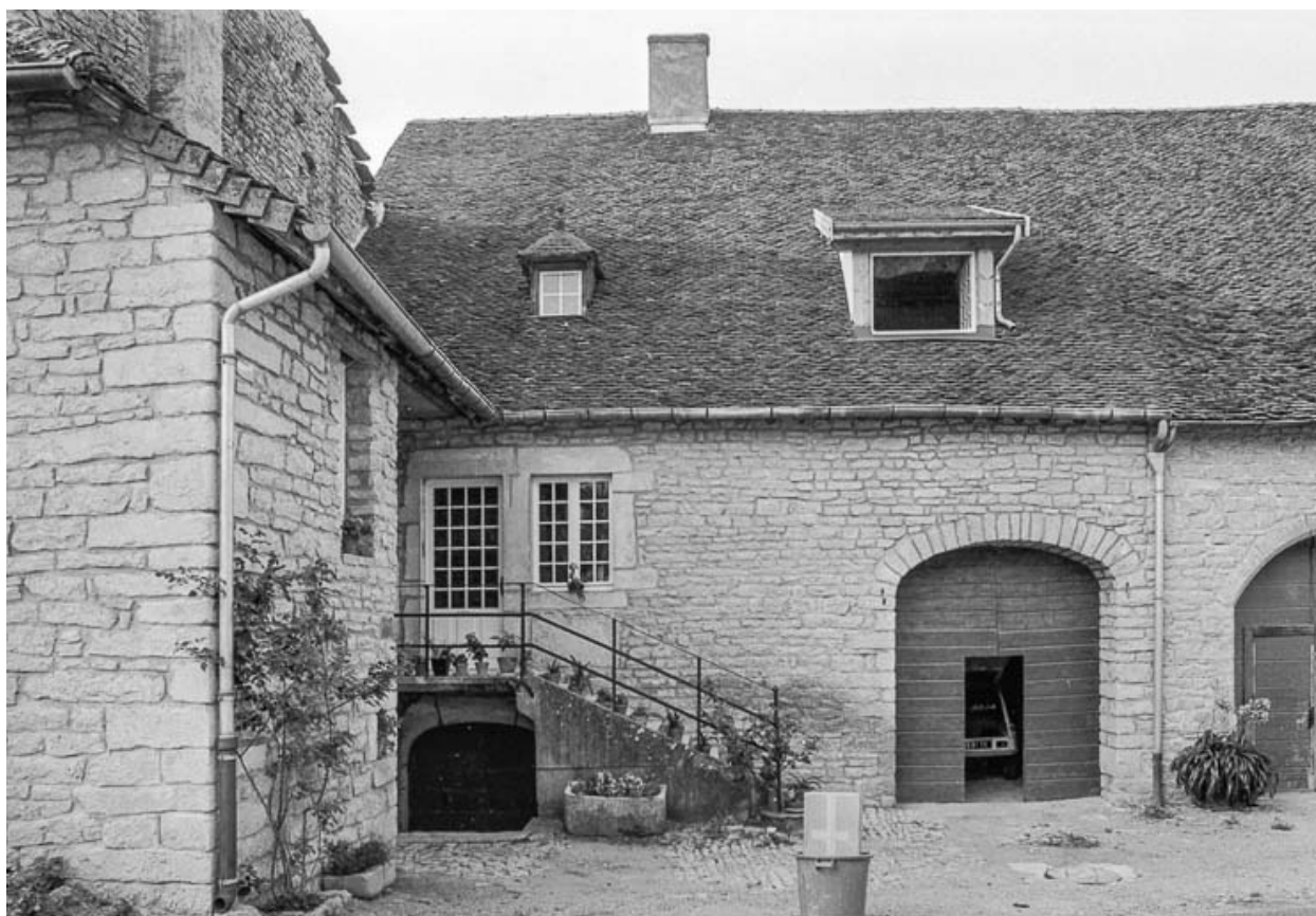
Ferme cadastrée AD 322 : façade antérieure.
