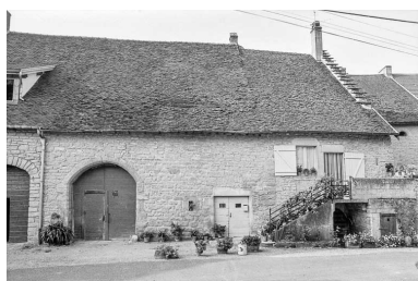
Ferme cadastrée AD 323 : façade antérieure. Phot. Bernard Pontefract IVR43_19763900303Z
