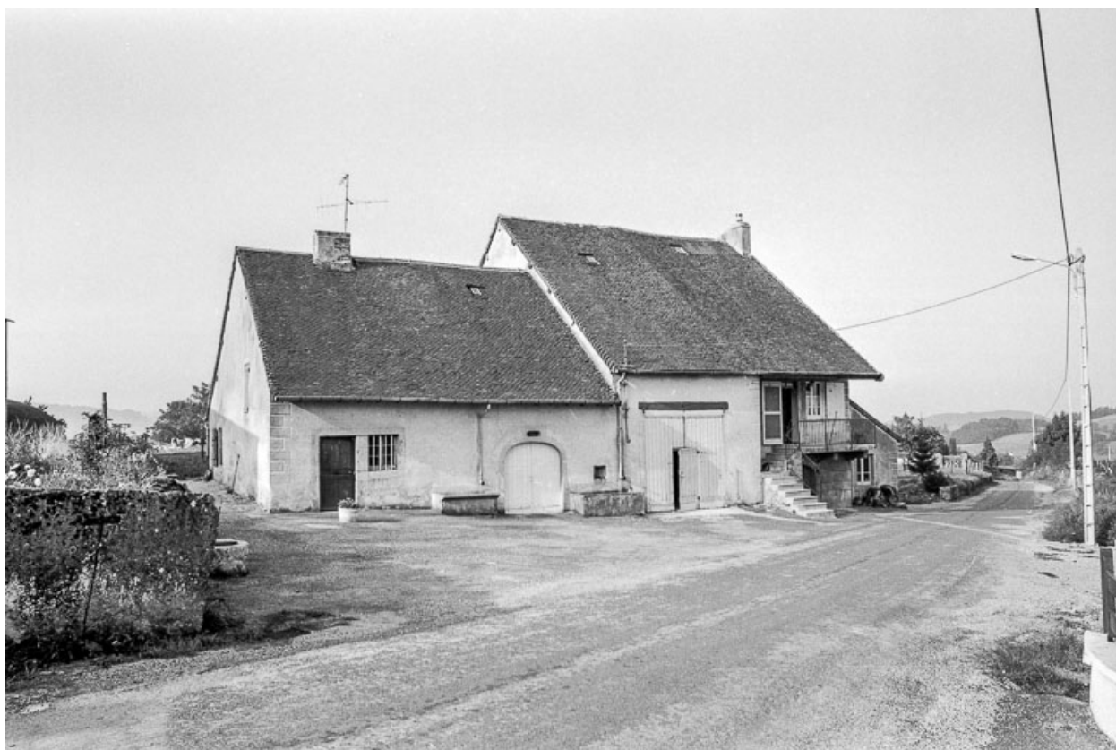
Ferme cadastrée AD 332 : façade antérieure.
