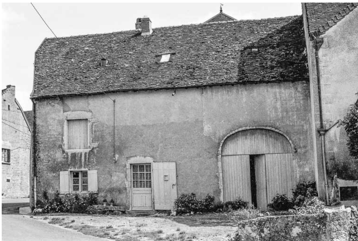
Ferme cadastrée AD 329 : façade antérieure.
