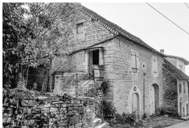
Ferme située rue du Meix Dagay : vue d'ensemble. Phot. Bernard Pontefract IVR43_19763900298Z
