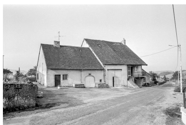
Ferme cadastrée AD 332 : façade antérieure. Phot. Bernard Pontefract IVR43_19763900307Z
