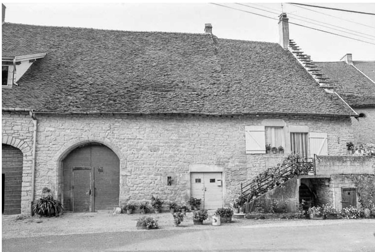
Ferme cadastrée AD 323 : façade antérieure.
