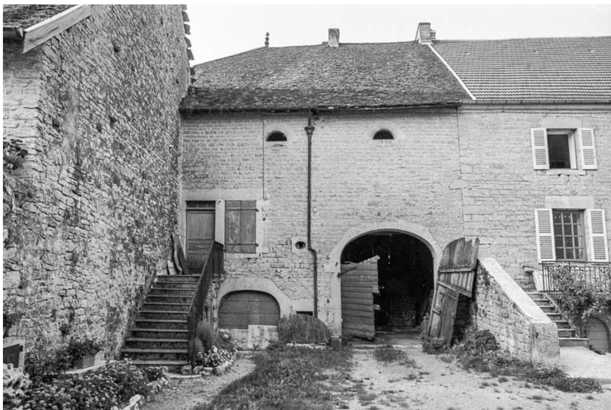
Ferme cadastrée AD 324 : façade antérieure.
