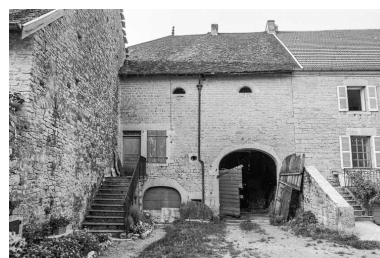
Ferme cadastrée AD 324 : façade antérieure. Phot. Bernard Pontefract IVR43_19763900304Z
