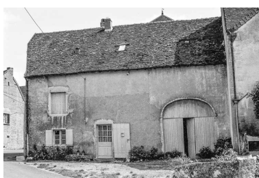
Ferme cadastrée AD 329 : façade antérieure. Phot. Bernard Pontefract IVR43_19763900291Z
