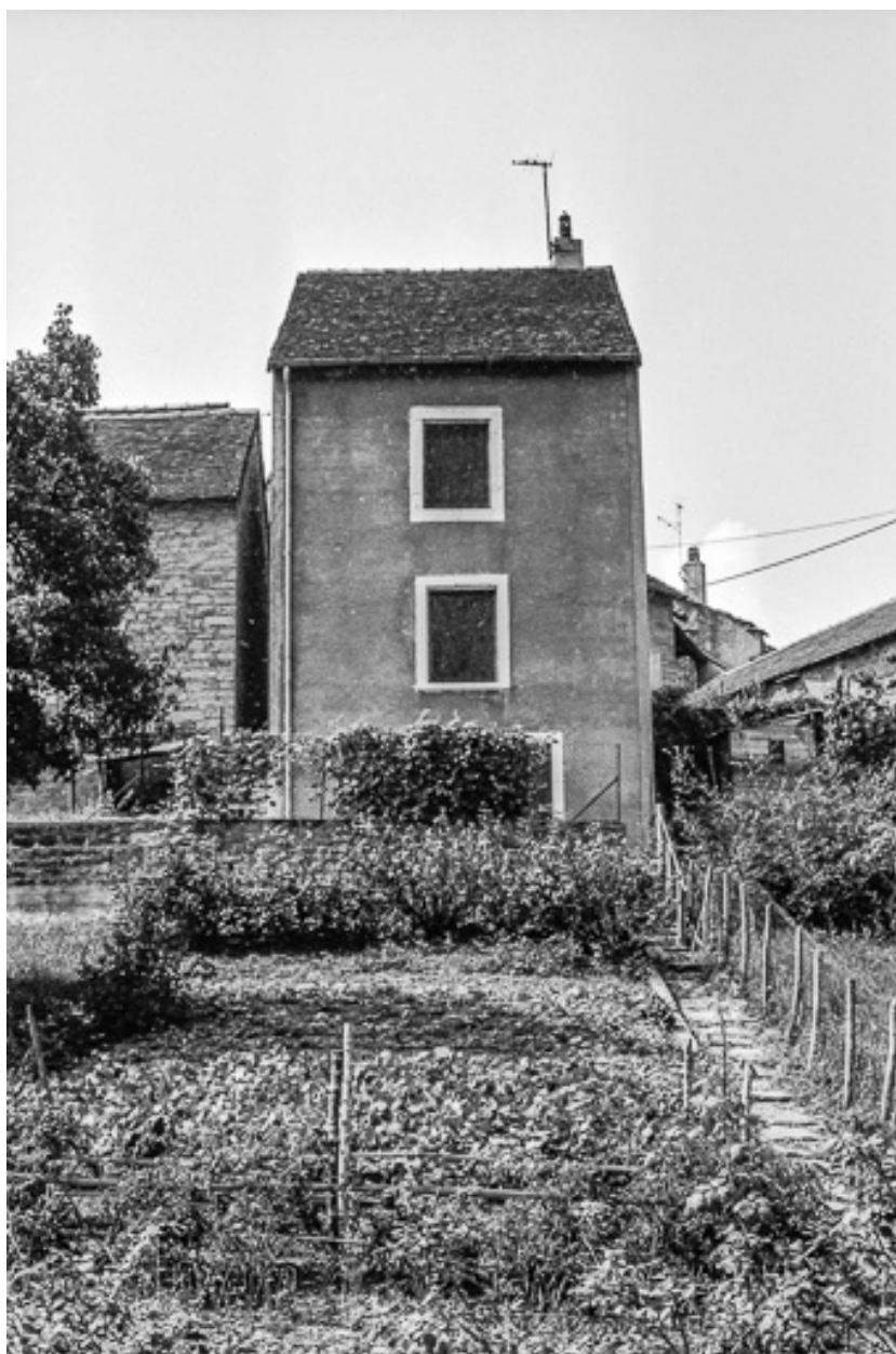
Maison cadastrée AD 114 : façade postérieure et jardin.
