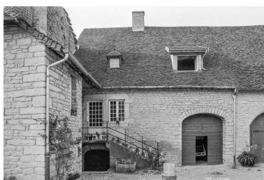
Ferme cadastrée AD 322 : façade antérieure. Phot. Bernard Pontefract IVR43_19763900302Z
