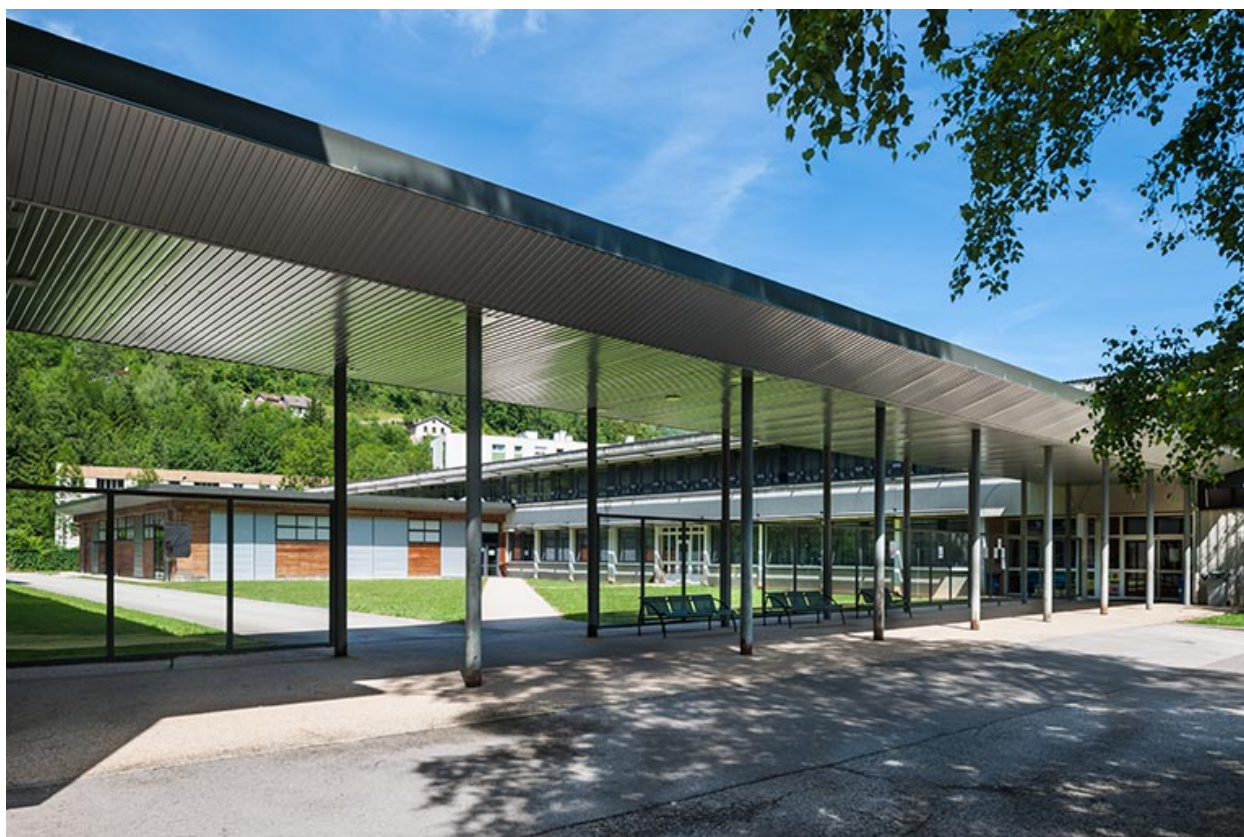
Passage couvert reliant l'atelier à l'externat tertiaire.
