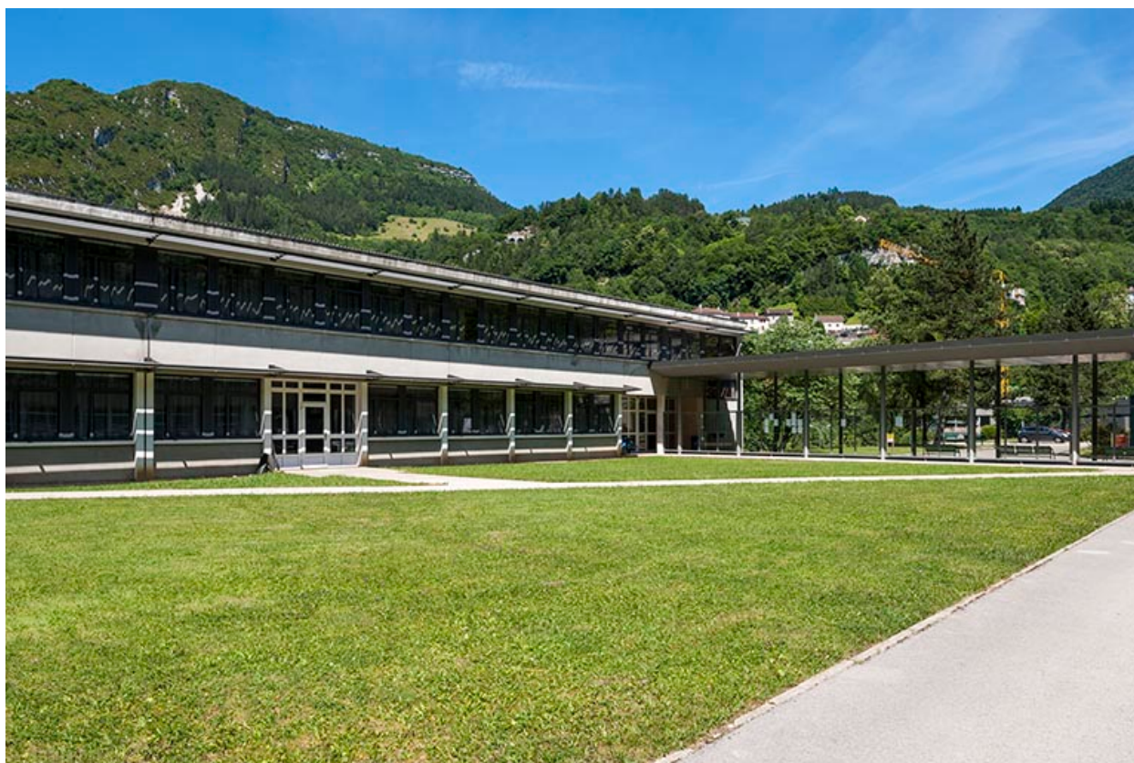
Externat tertiaire : façade antérieure.
