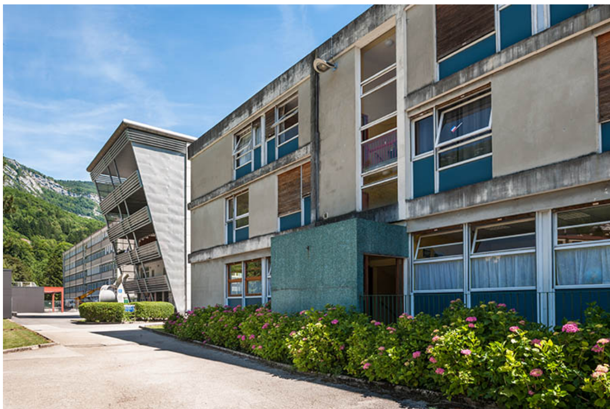
Administration : vue depuis le côté est avec au second plan l'extension de l'internat.
