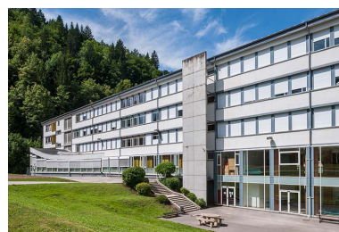
Internat : façade antérieure rénovée et aménagements extérieurs. Phot. Jérôme Mongreville IVR43_20143900451NUC4A
