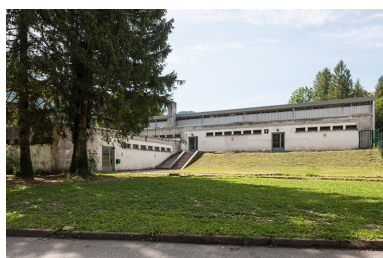
Externat : vue postérieure. Phot. Jérôme Mongreville IVR43_20143900447NUC4A
