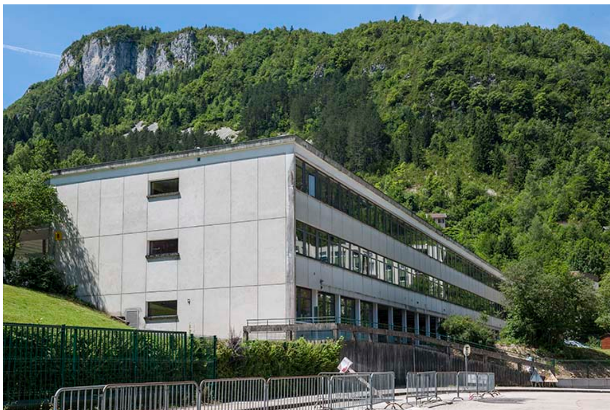
Externat : façade postérieure.
