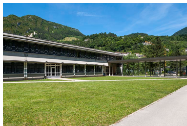
Externat tertiaire : façade antérieure. Phot. Jérôme Mongreville IVR43_20143900441NUC4A
