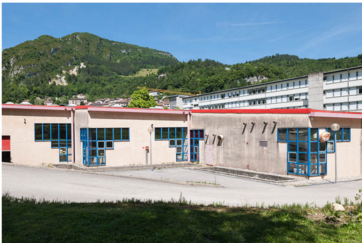
Atelier, ancien atelier mécanique : façade latérale sud.
