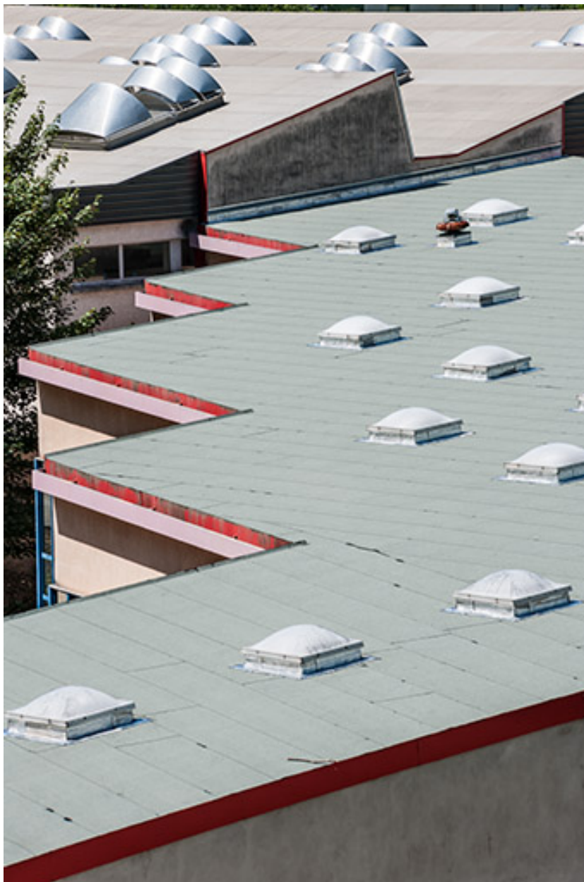
Toitures des deux ateliers : détail.
