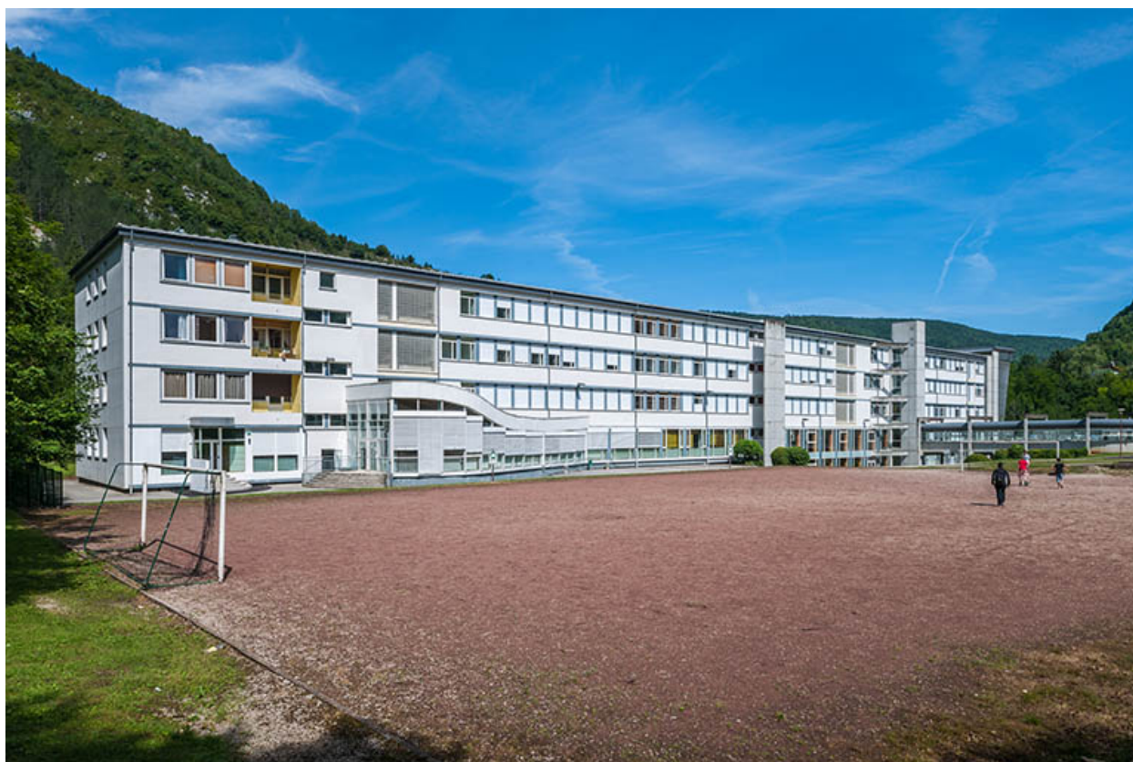
Internat : façade Est, terrain de football.
