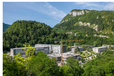
Vue d'ensemble de la cité scolaire. Phot. Jérôme Mongreville IVR43_20143900468NUC4A
