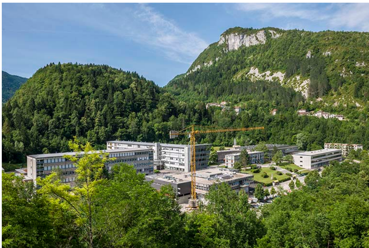
Vue d'ensemble de la cité scolaire.
