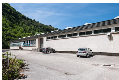
Atelier : façade postérieure. Phot. Jérôme Mongreville IVR43_20143900430NUC4A
