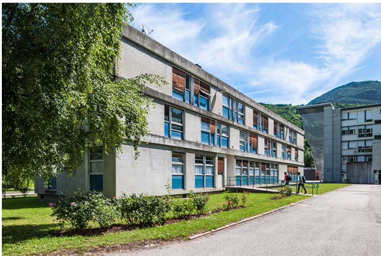
Administration : façade postérieure.
