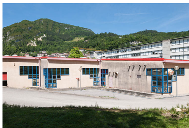
Atelier, ancien atelier mécanique : façade latérale sud. Phot. Jérôme Mongreville IVR43_20143900429NUC4A
