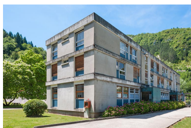
Administration : façade antérieure. Phot. Jérôme Mongreville IVR43_20143900420NUC4A
