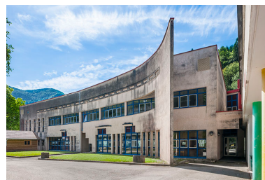
Façade antérieure de l'ancien atelier mécanique. Phot. Jérôme Mongreville IVR43_20143900424NUC4A
