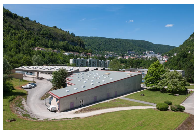
Ateliers : vue d'ensemble des toitures. Phot. Jérôme Mongreville IVR43_20143900427NUC4A
