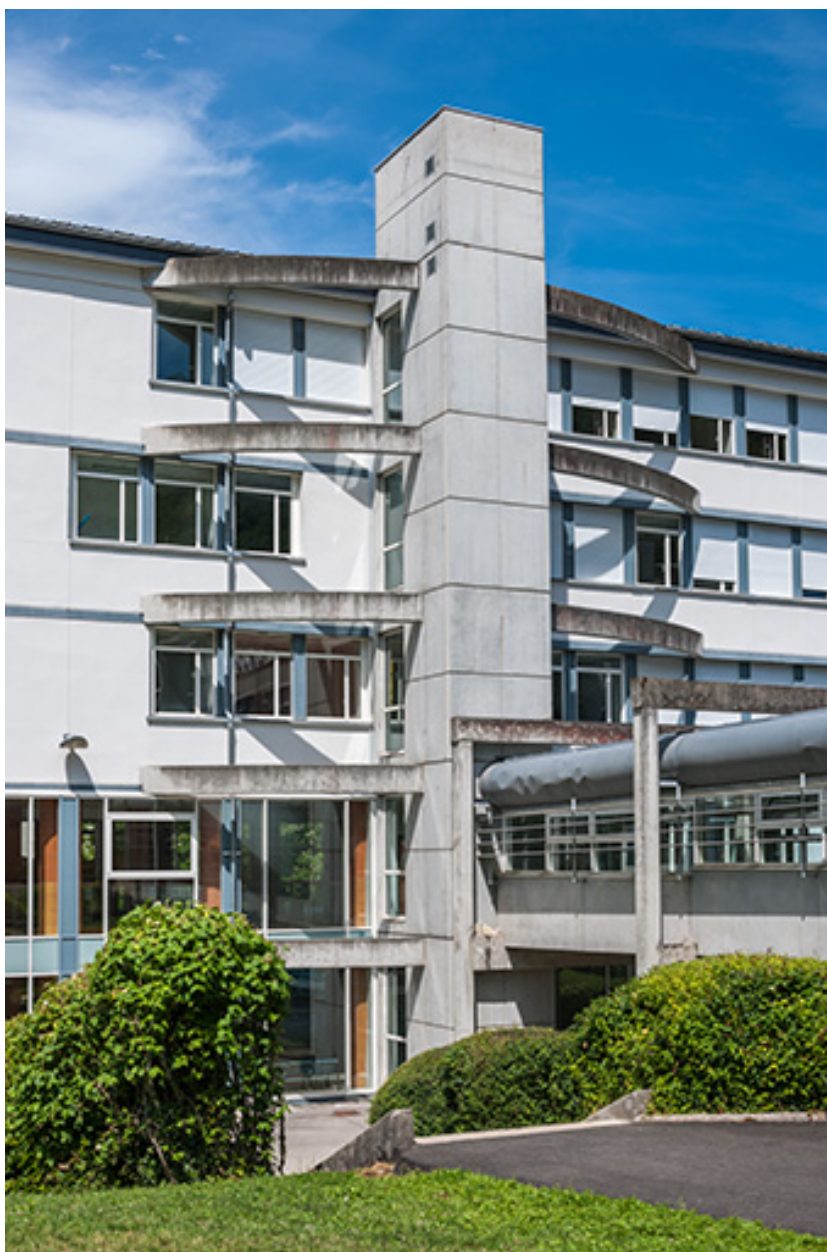
Internat : détail de la façade antérieure.
