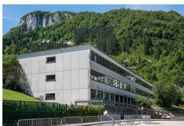
Externat : façade postérieure. Phot. Jérôme Mongreville IVR43_20143900439NUC4A
