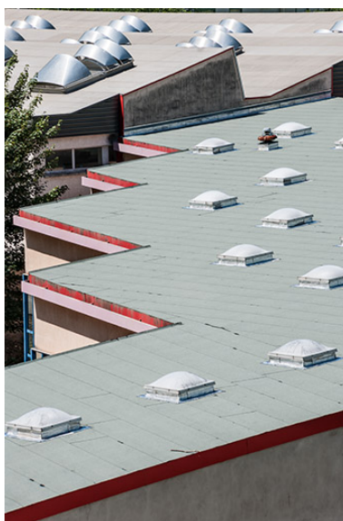
Toitures des deux ateliers : détail. Phot. Jérôme Mongreville IVR43_20143900428NUC4A
