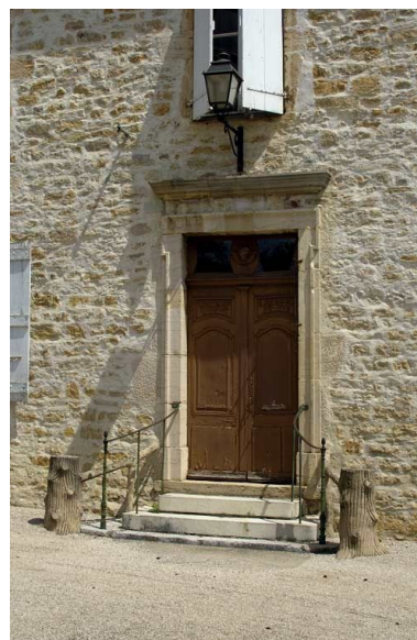
Façade antérieure, détail de l'ancienne porte d'entrée. Phot. Michel Thierry IVR26_20047101095NUC2A
