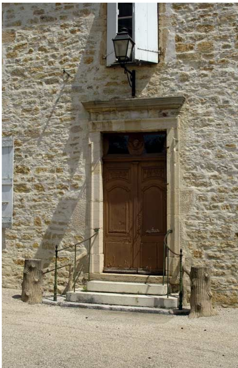
Façade antérieure, détail de l'ancienne porte d'entrée.
