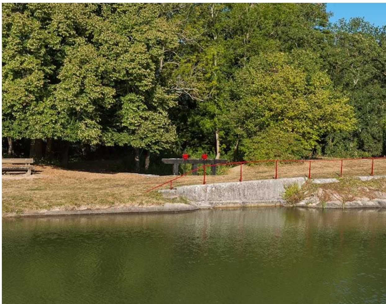
Arrivée d'eau avec les deux vannes.
