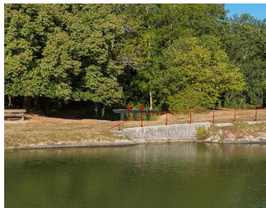
Arrivée d'eau avec les deux vannes. Phot. Pierre-Marie Barbe-Richaud IVR26_20128900513NUC2AQ
