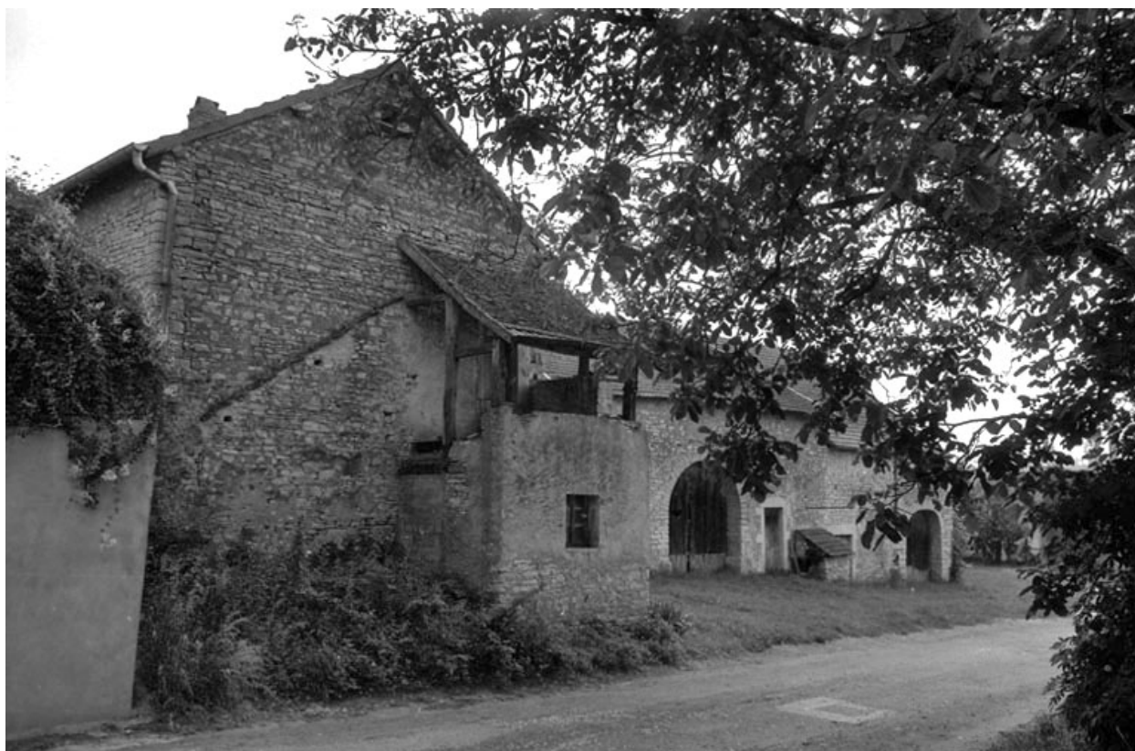
Ferme située rue Basse de l'Eglise.
