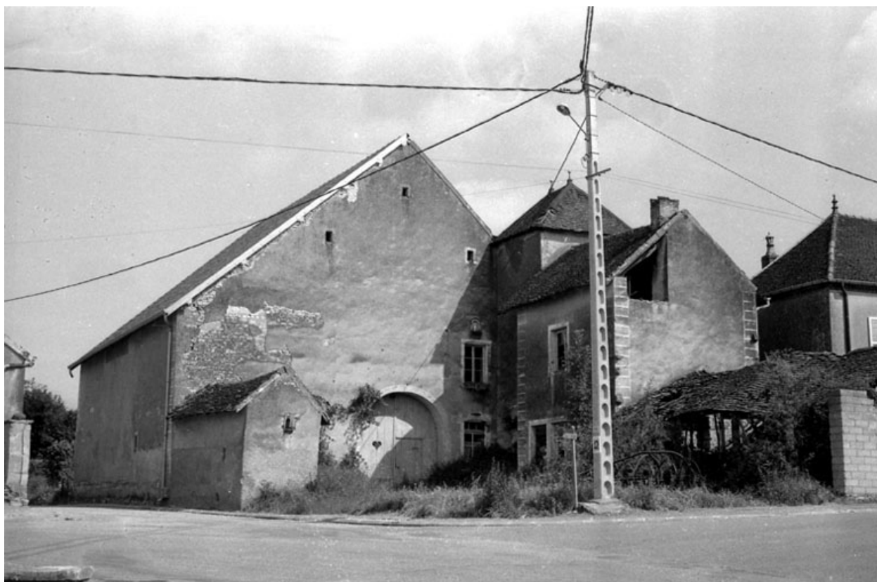
Ferme située place de l'Eglise
