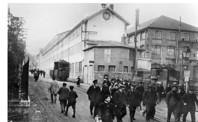
L'usine des Fonteneilles. Phot. Jérôme Mongreville IVR43_20019000193X
