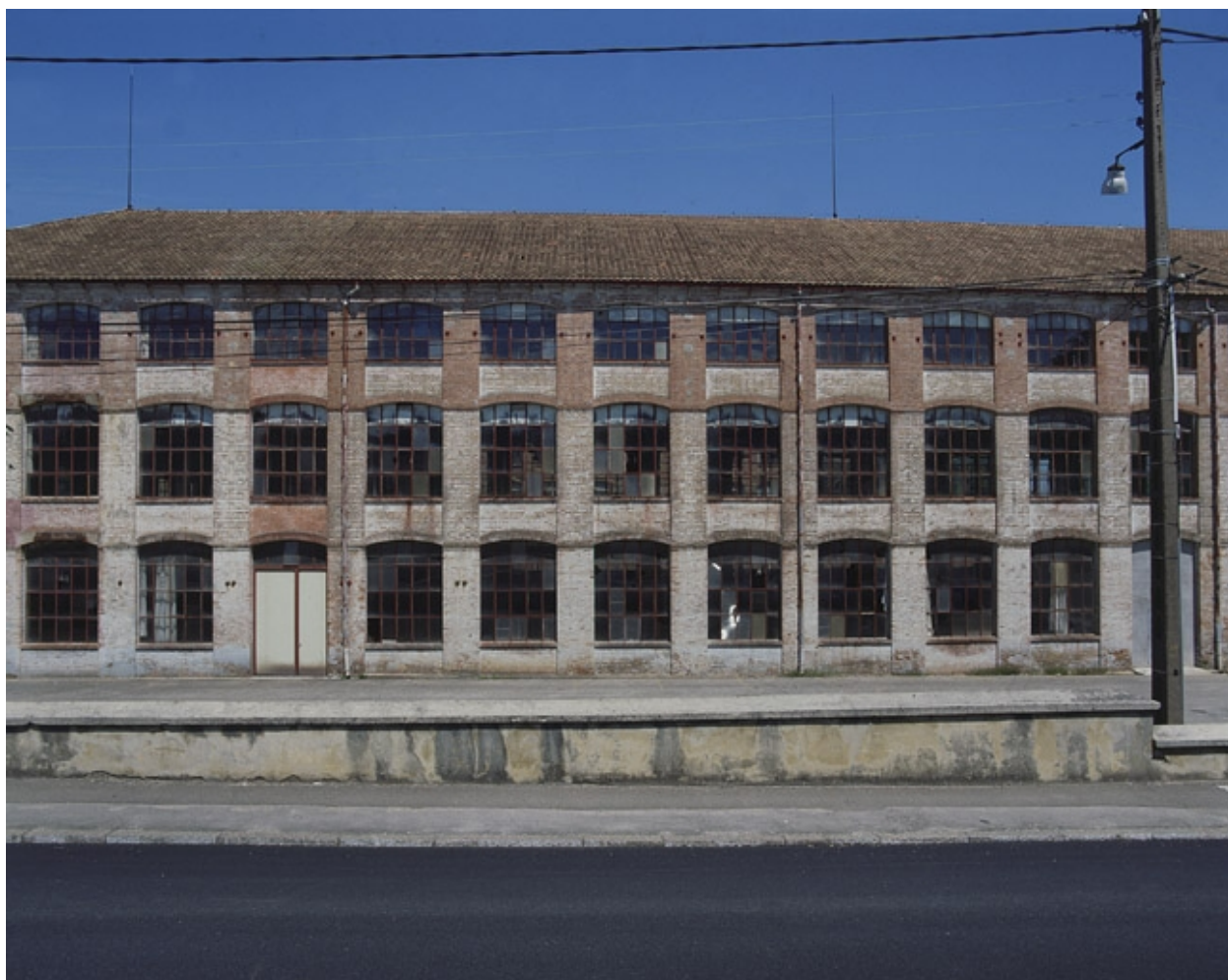
Travées de la façade sud.
