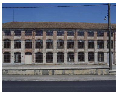
Travées de la façade sud.
