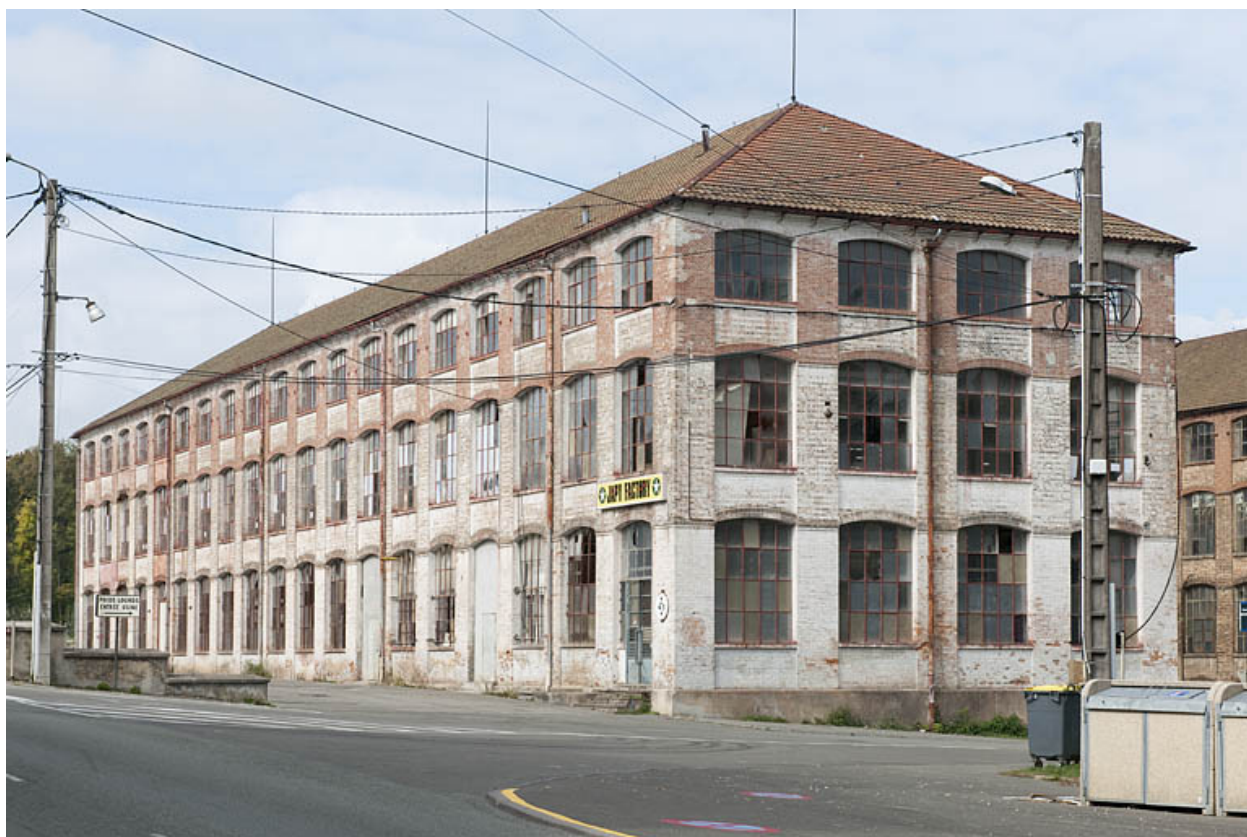
Vue d'ensemble rapprochée depuis le sud-est.
