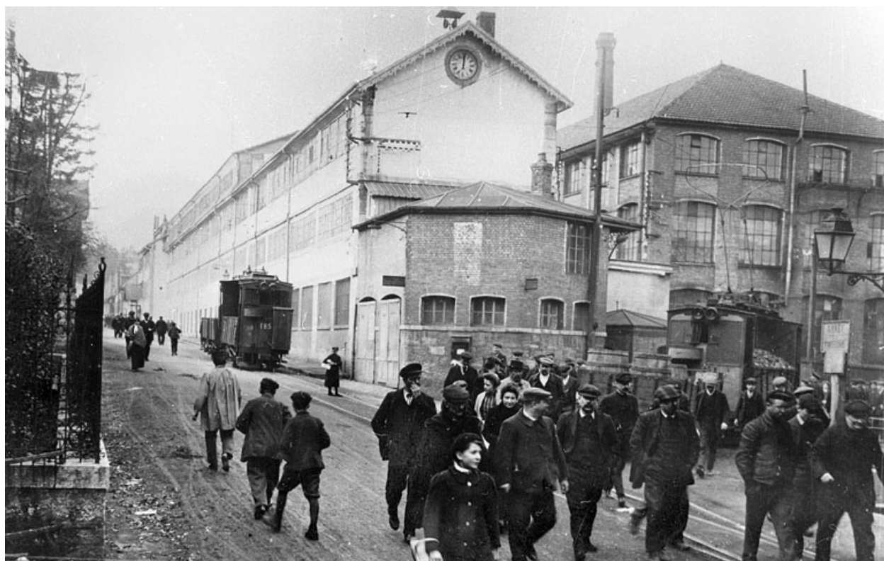
L'usine des Fonteneilles.
