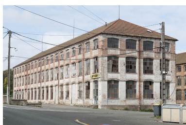
Vue d'ensemble rapprochée depuis le sud-est.
