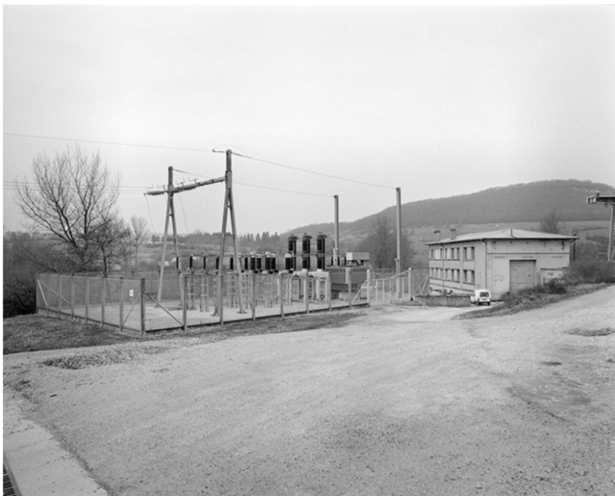
Transformateur et salle des machines.
