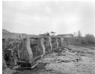
Barrage et vannes-secteurs. Phot. Jérôme Mongreville IVR43_19963900139X
