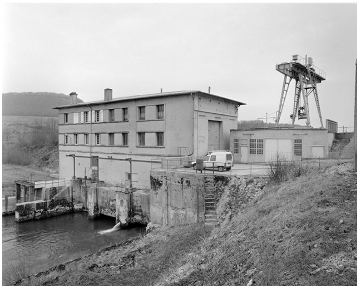
Salle des machines et atelier de réparation.
