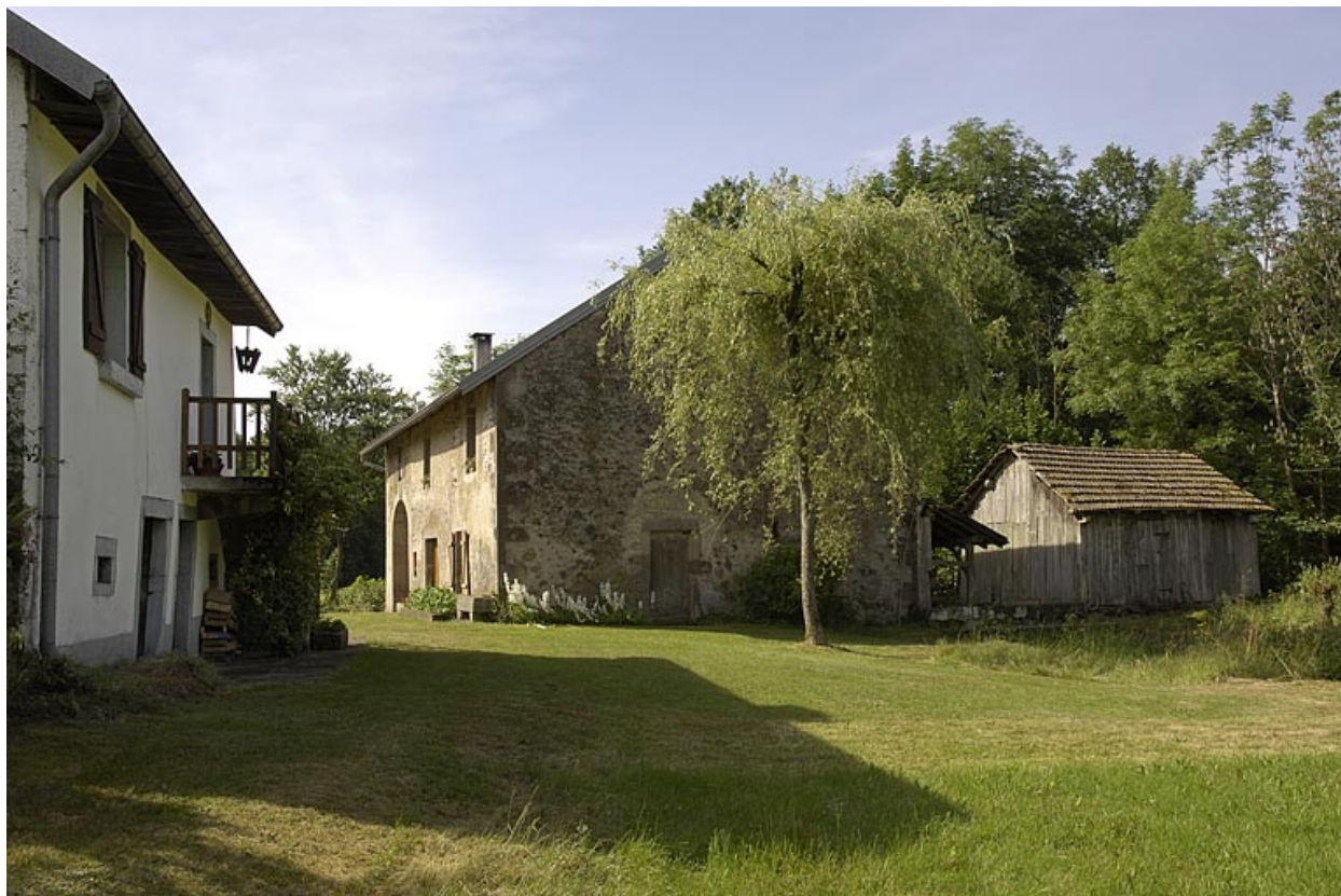
Logement, moulin et huilerie depuis le nord.
