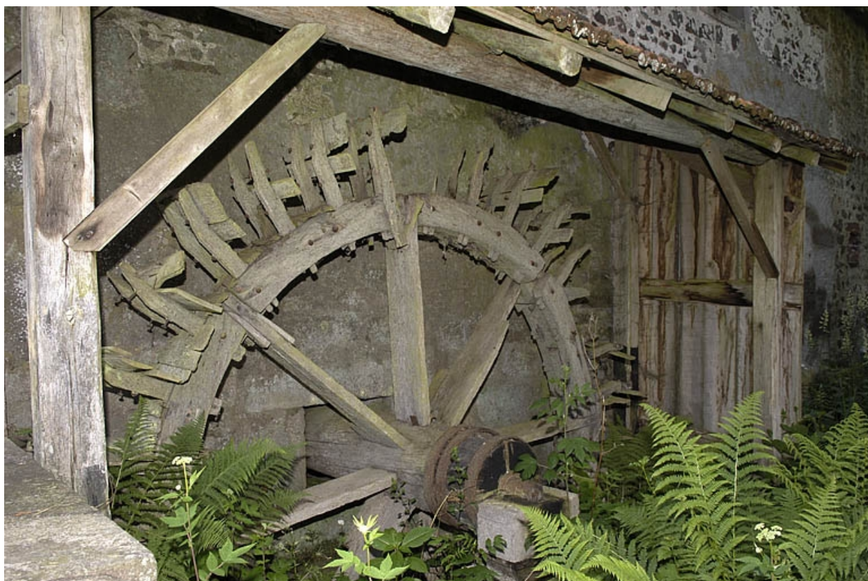
Détail de la roue hydraulique en dessous.
