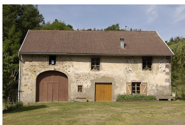
Façade est du moulin. Phot. Jérôme Mongreville IVR43_20057000278NUCA
