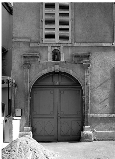
Détail du portail d'entrée.
