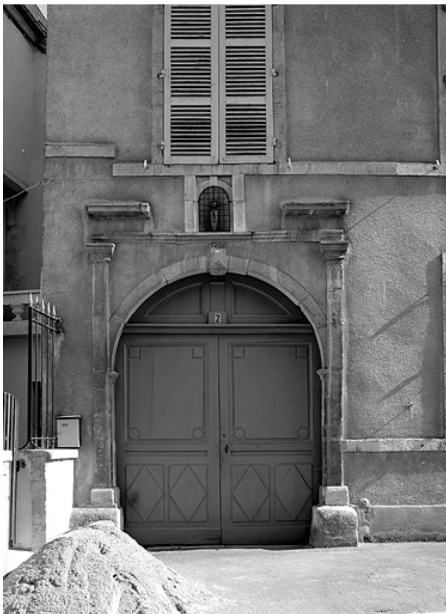
Détail du portail d'entrée.
