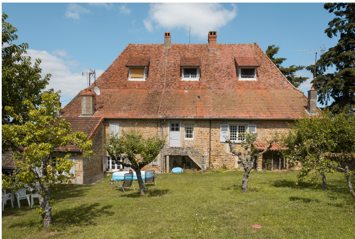
Façade postérieure du logement.
