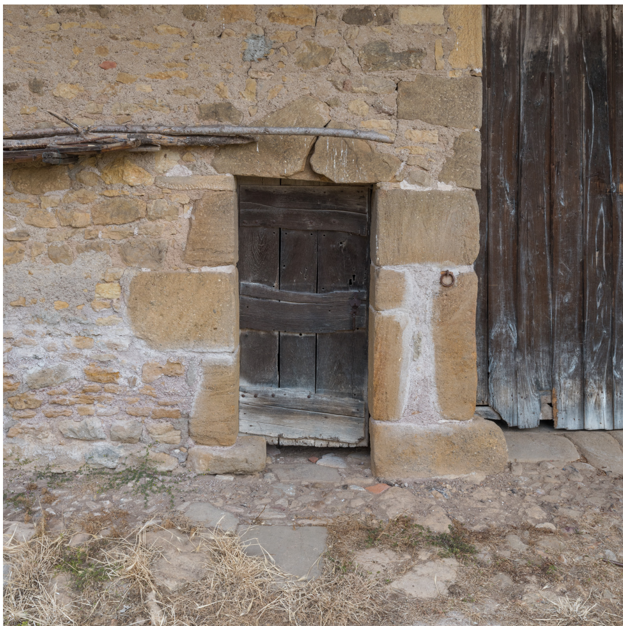
Façade antérieure du bâtiment agricole. Porte piétonne.
