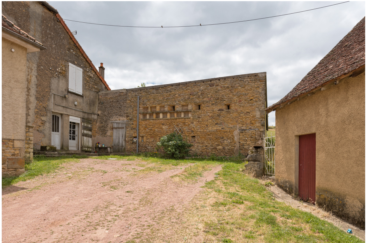
Mur d'une dépendance agricole (soue).
