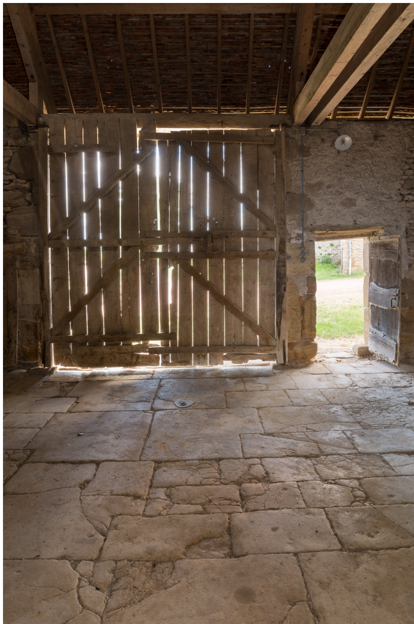
Bâtiment agricole. Vue intérieure de la remise.
