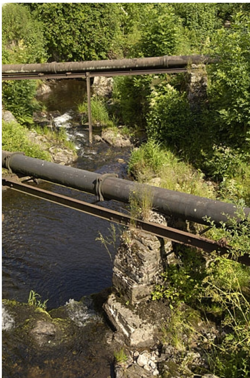
Conduites forcées enjambant le Breuchin.
