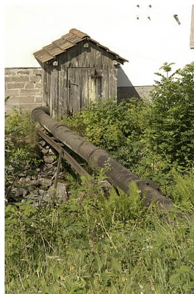
Conduite forcée et bâtiment d'eau abritant la turbine. Phot. Jérôme Mongreville IVR43_20057000288NUCA
