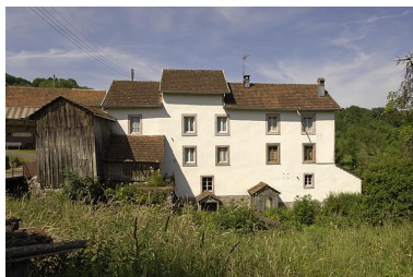
Façade est de la minoterie. Phot. Jérôme Mongreville IVR43_20057000287NUCA
