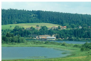
Vue d'ensemble depuis l'ouest. Phot. Laurent Poupard IVR43_19913901219ZA
