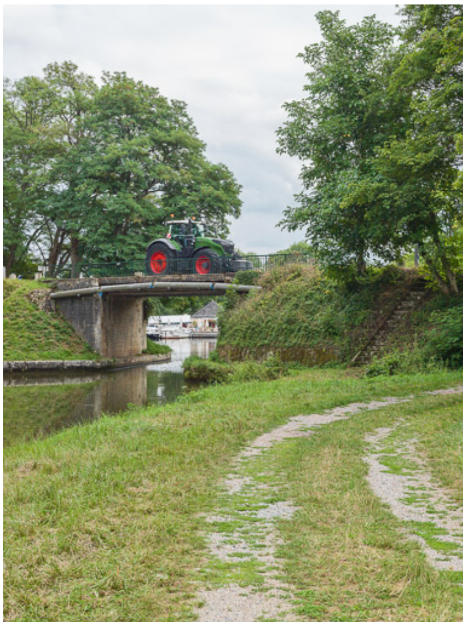
Vue d'ensemble du pont.
